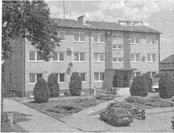
Budynek Urzędu Gminy
