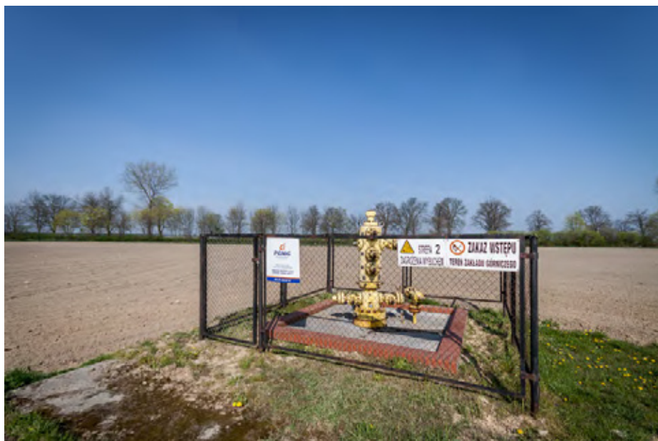
fot. 4. Strefa przyodwiertowa otworu Czarna Wieś-5
