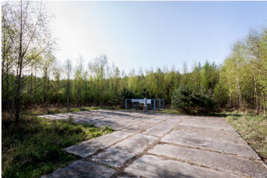
fot. 1. Strefa przyodwiertowa otworu Czarna Wieś-4
