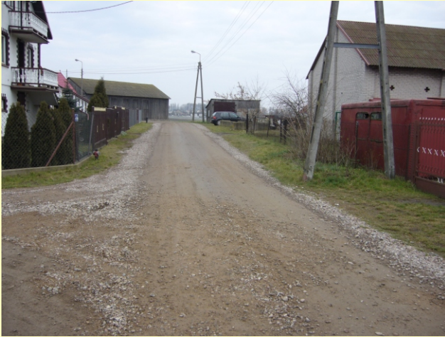
Nawierzchnia z tłucznia na ul. Zacisznej
