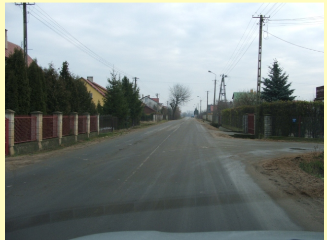
Nawierzchnia bitumiczna na ul. Rolniczej
