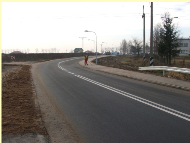
Nowa nawierzchnia bitumiczna, chodniki i oświetlenie przy ul. Przemysłowej
