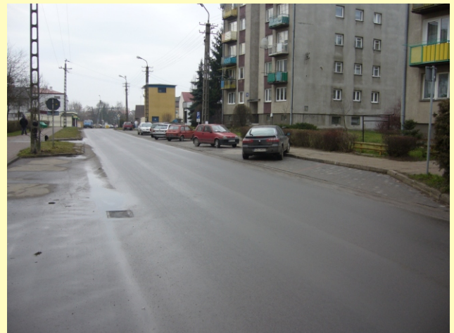
Nawierzchnia bitumiczna na ul. Osiedlowej
