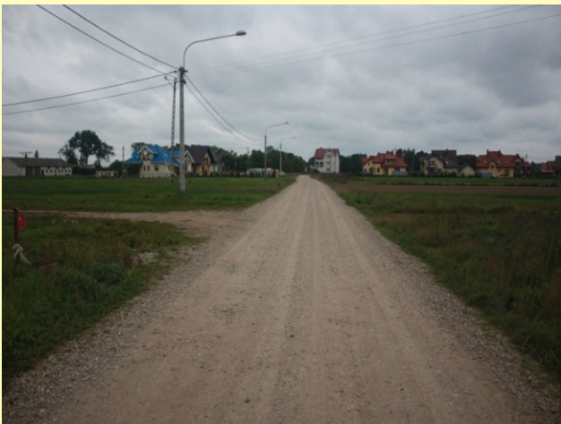
Nawierzchnia z tłucznia na Alei Jana Pawła II
