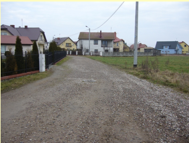
Nawierzchnia z tłucznia na ul. Kisielewskiego
