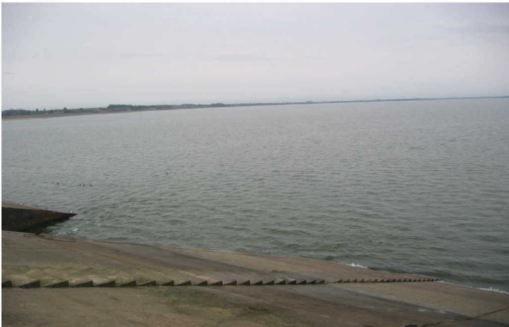
Fot. 20 Widok na tamę Zbiornika Jeziorsko
