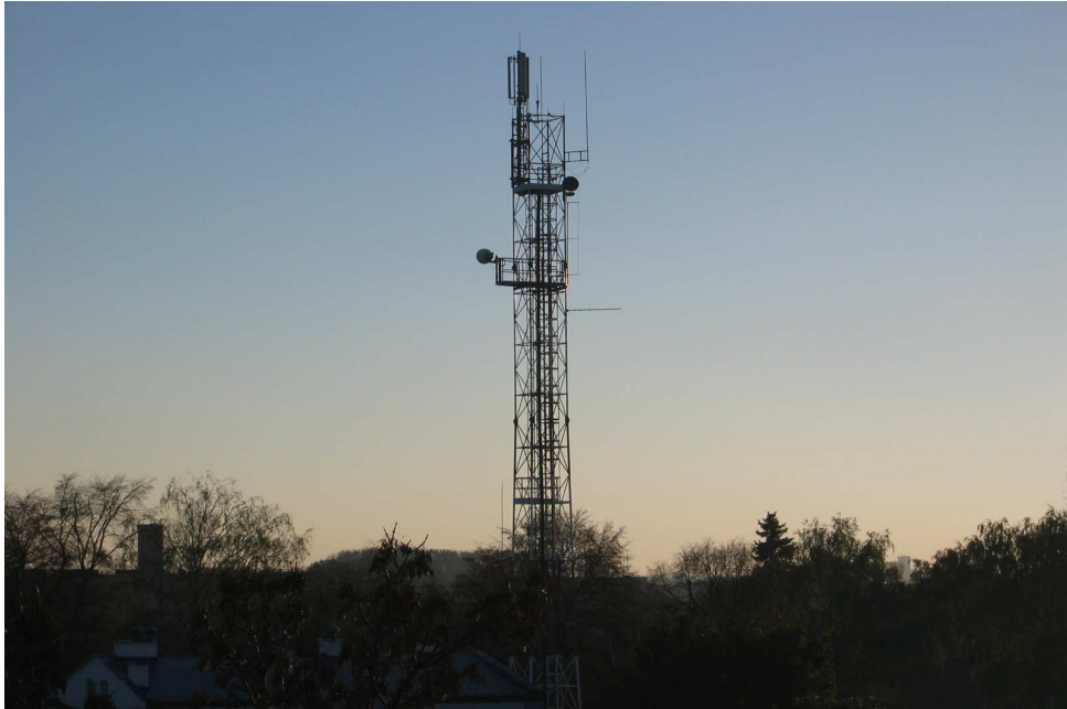
Fot. 13 Maszt telefonii komórkowej w Poddębicach
