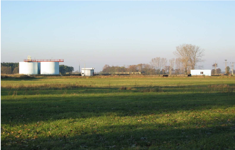
Fot. 25 Oczyszczalnia ścieków w Wartkowicach
