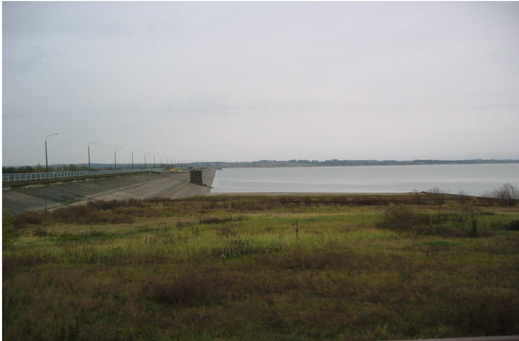
Fot. 19 Widok na tamę Zbiornika Jeziorsko
