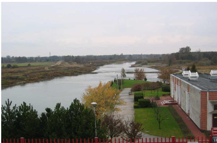
Fot. 21 Elektrownia wodna przy Zbiorniku Jeziorsko
