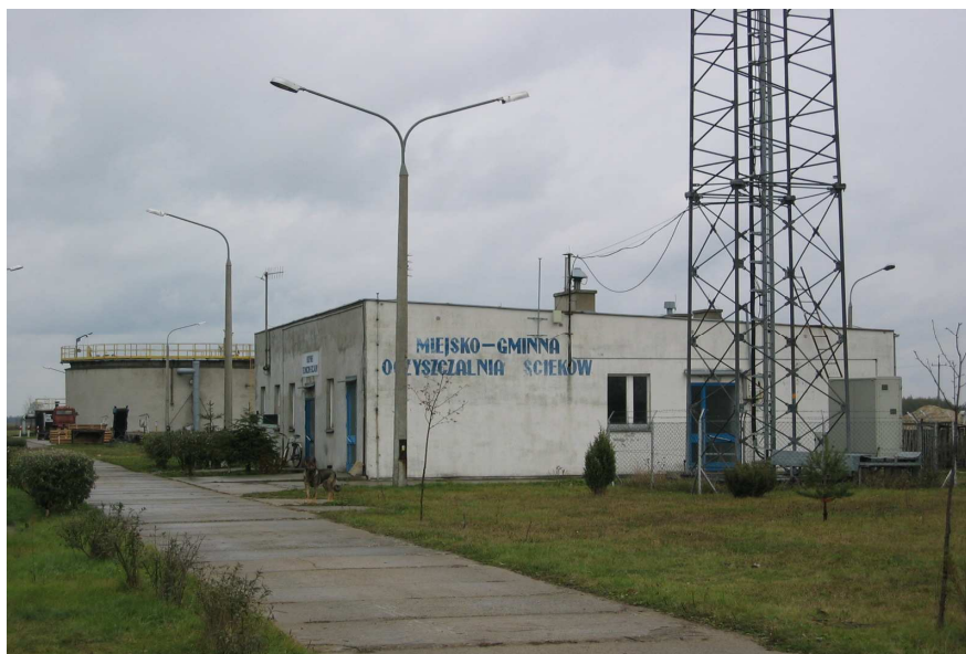
Fot. 15 Oczyszczalnia ścieków w Uniejowie
