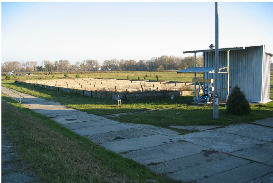
Fot. 24 Oczyszczalnia ścieków w Wartkowicach
