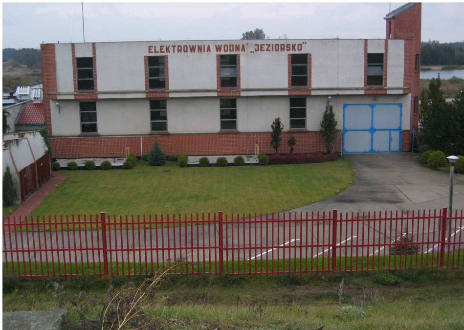
Fot. 23 Elektrownia Wodna – budynek główny
