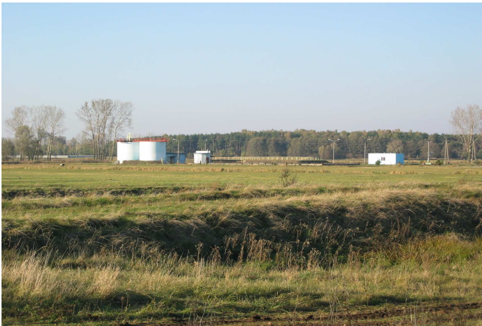
Fot. 26 Oczyszczalnia ścieków w Wartkowicach
