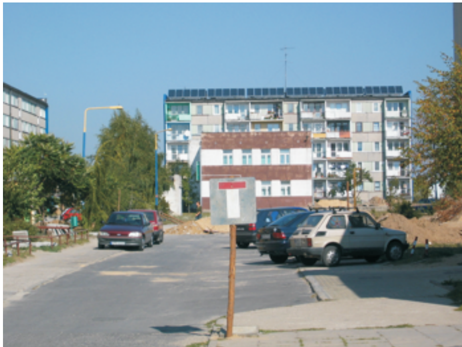
Fot. 10 Instalacja solarna w Poddębicach
