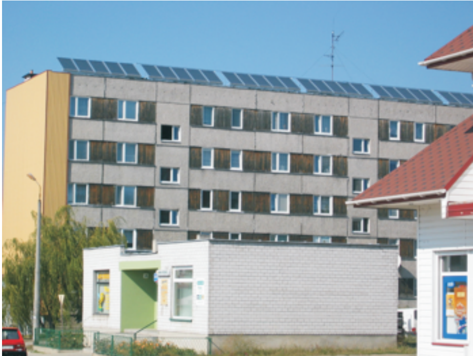
Fot. 9 Instalacja solarna w Poddębicach
