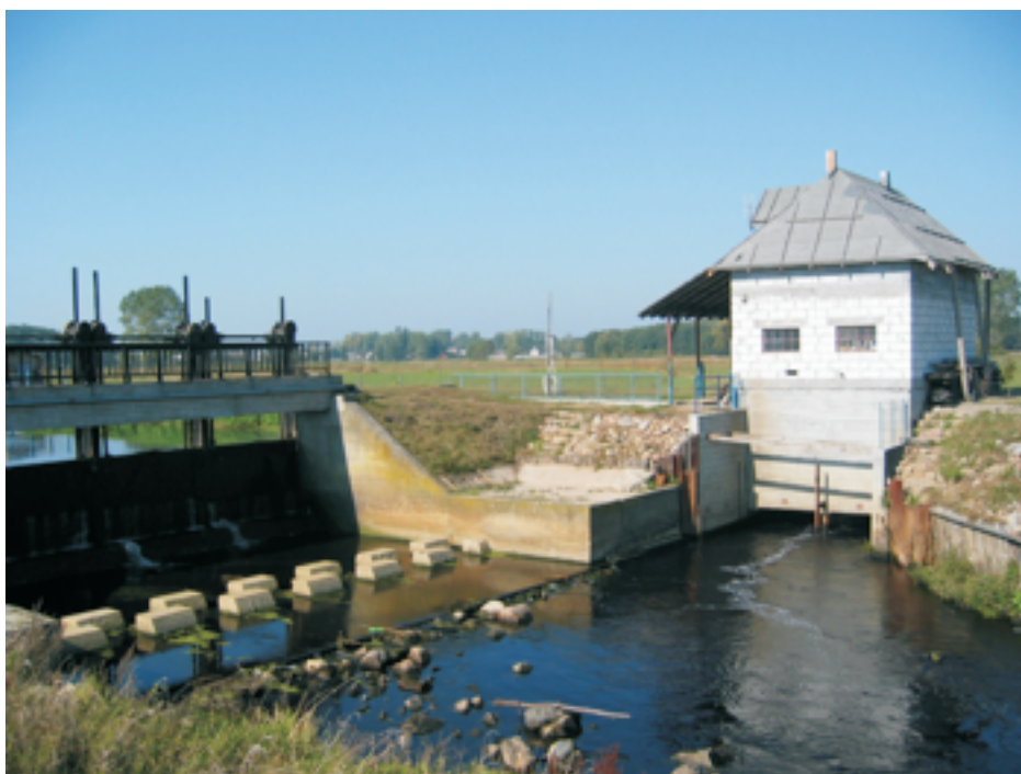
Fot. 1 Elektrownia wodna na rzece Ner Wólka, gm. Wartkowice
