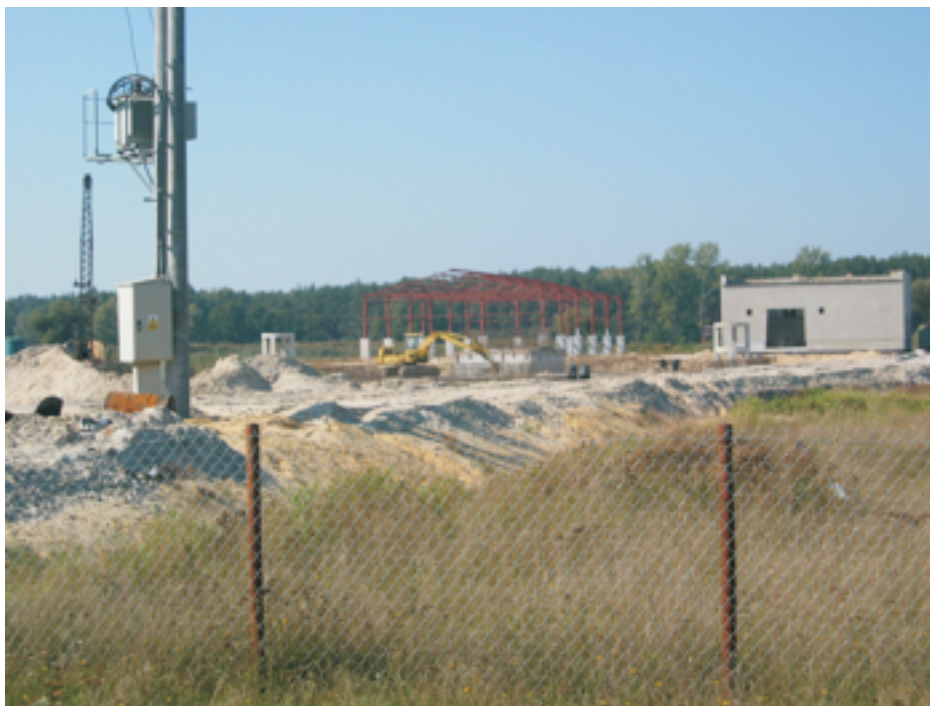
Fot. 11 Budowa oczyszczalni ścieków w Poddębicach
