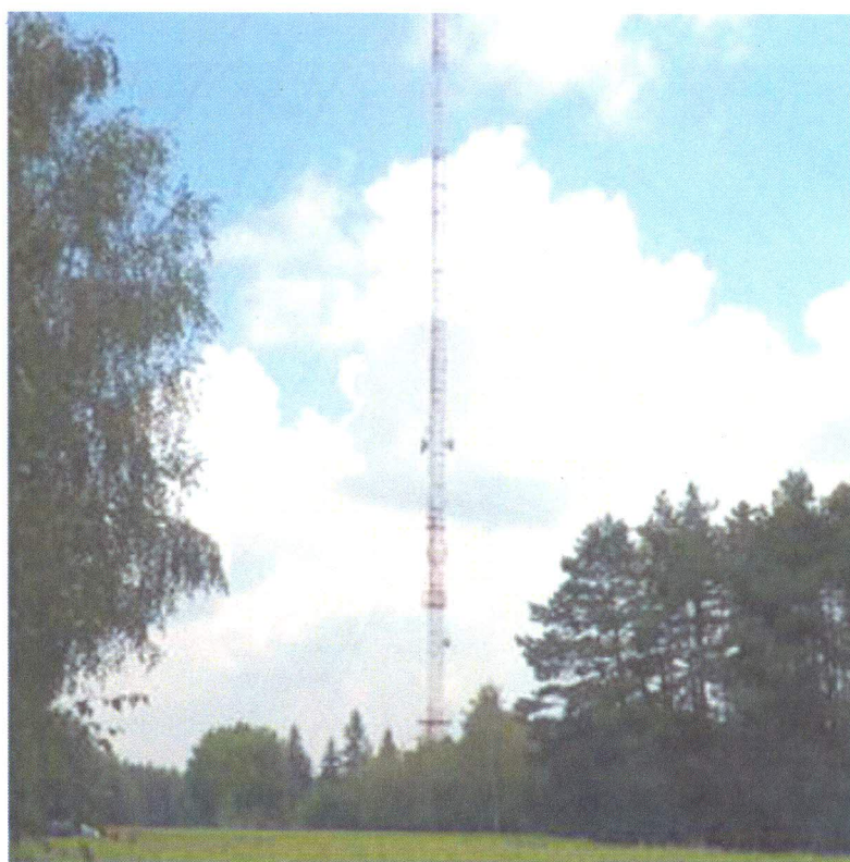
Fot. 1. RTCN Łódź/Zygry – widok obiektu
