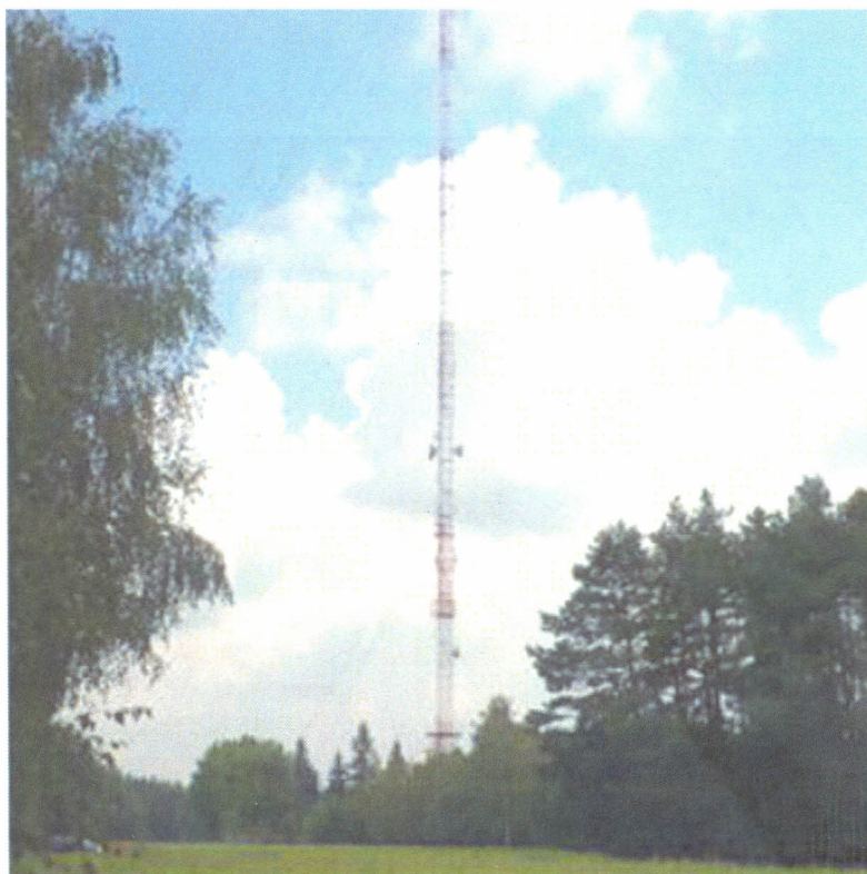
Fot. 1. RTCN Łódź/Zygry – widok obiektu
