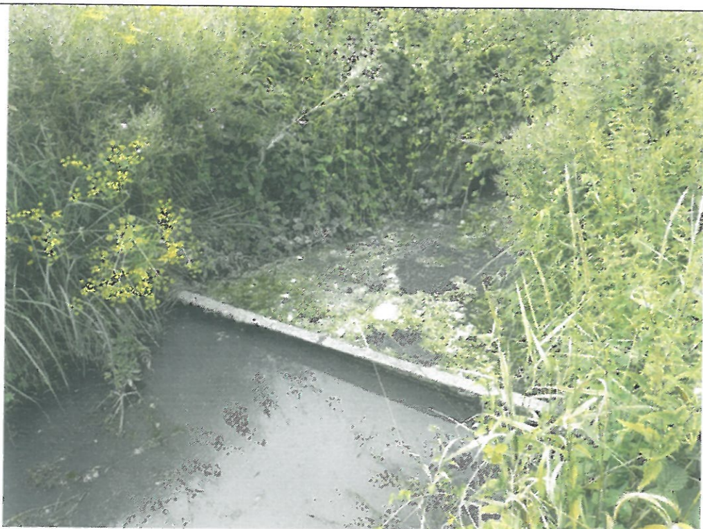
11. Obiekt nr2 - zastawka 1 - ceownik stalowy.
