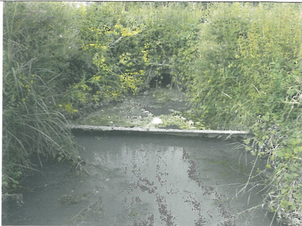
10. Obiekt nr2 - wlot z kolektora, zastawka 1.
