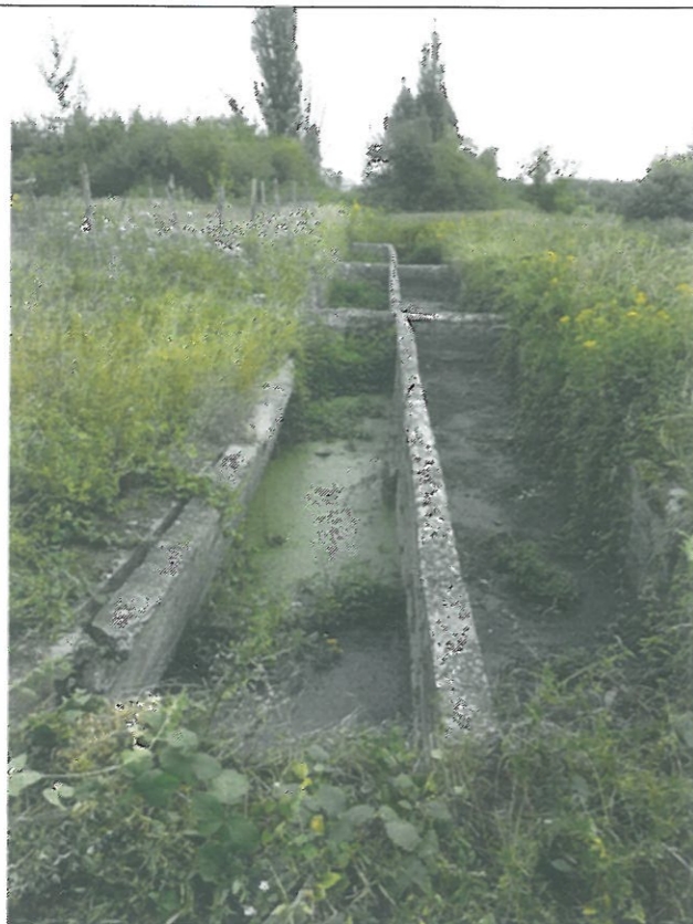
1. Obiekt nr1 - widok od strony zachodniej.
