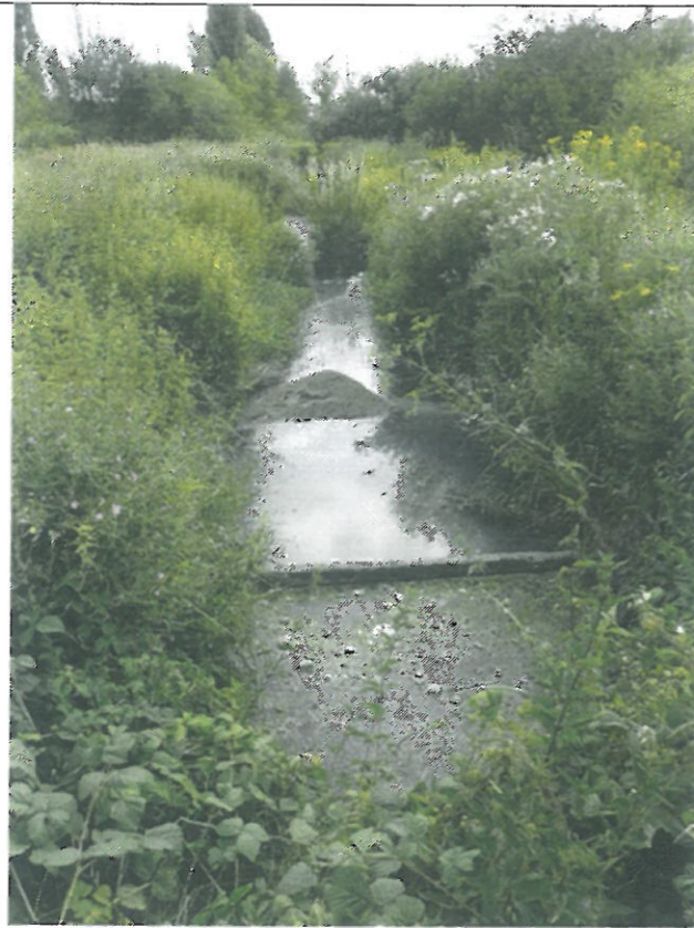
9. Obiekt nr2 - widok od strony zachodniej.
