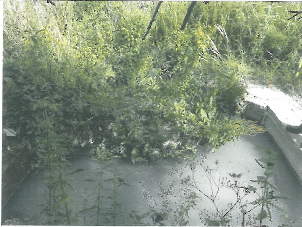
15. Obiekt nr2 - wylot wschodni do obiektu nr 1.
