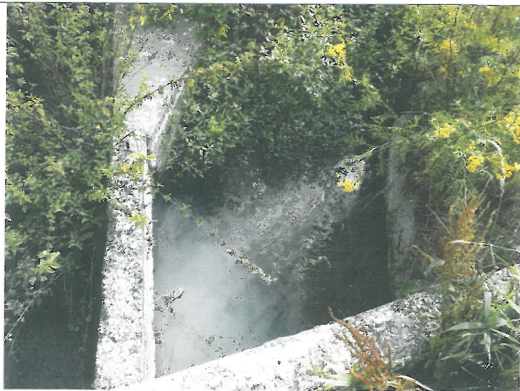
6. Obiekt nr1 - dopływ wschodni z obiektu nr 2.
