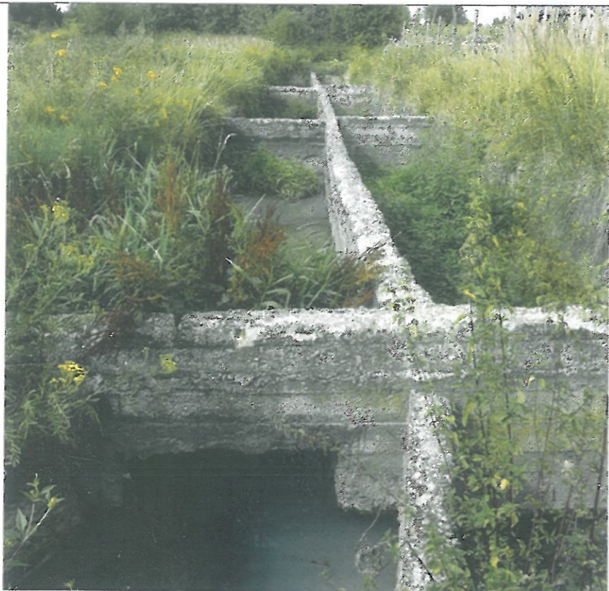
5. Obiekt nr1 - widok od strony wschodniej, otwór dopływowy.
