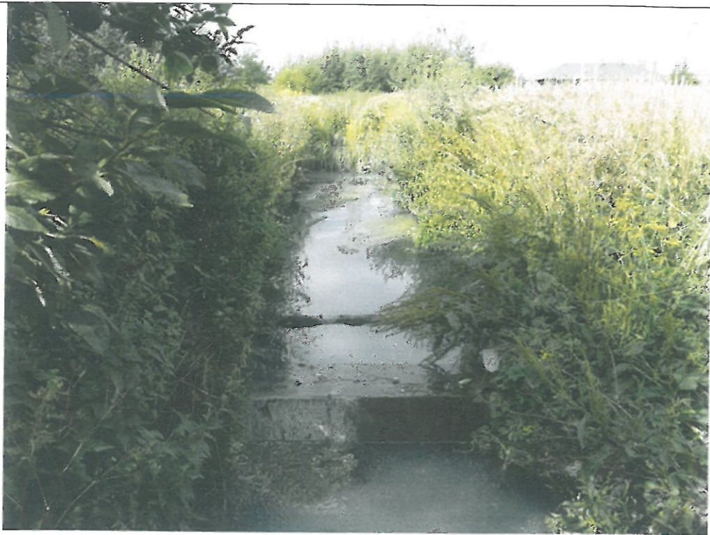
14. Obiekt nr2 - widok od wschodu, zastawka 4 (deski) i 5 (ściana betonowa).
