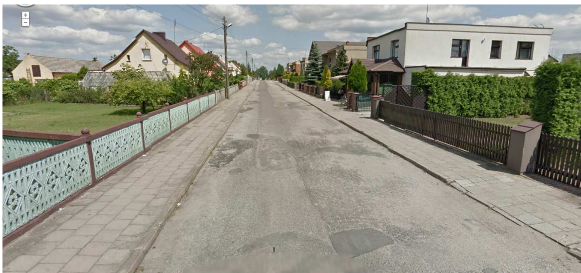
Foto. Teren inwestycji
