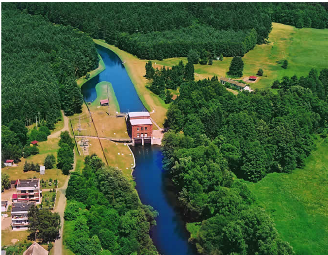
2.5. Elektrownia wodna w Podgajach z lotu ptaka
