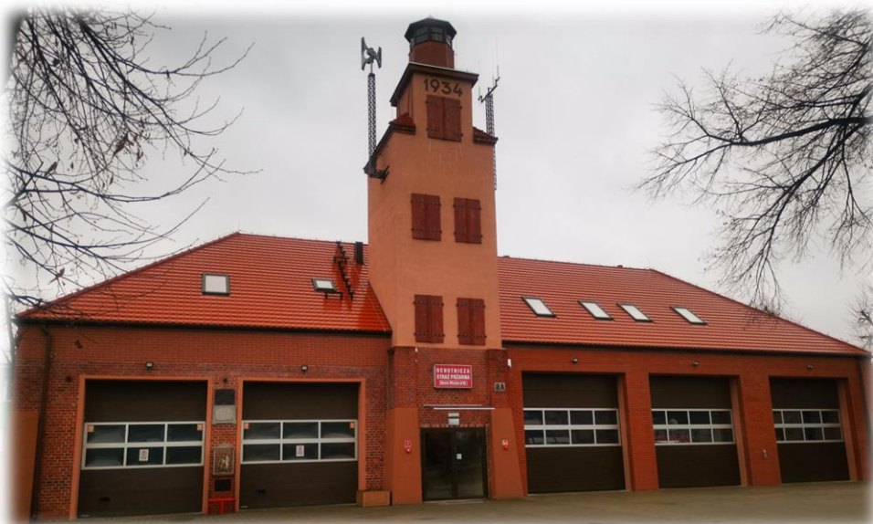
Zdjęcie 7. Remiza Strażacka w Nowym Mieście nad Wartą. Koszt inwestycji: 1 598 752,28 zł
