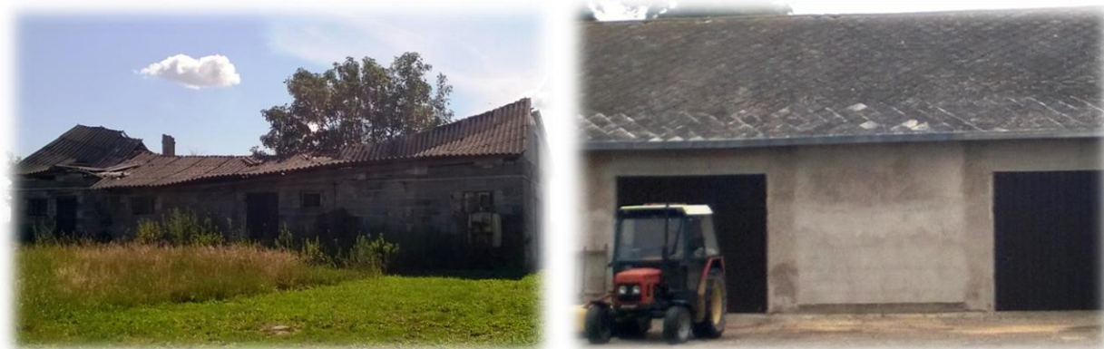
Rysunek 1. Wyroby azbestowo – cementowe: po lewej płyty faliste, po prawej płyty płaskie (źródło: materiały własne).
