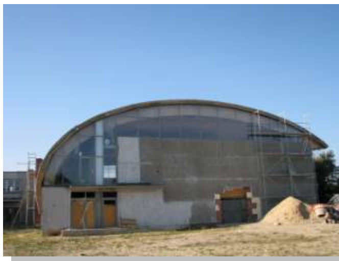
Foto. Hala sportowa (w budowie) przy Gimnazjum w Nowej Brzeźnicy.
