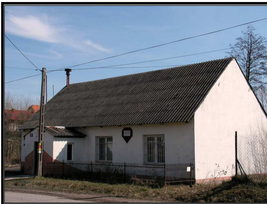
Budynek remizy OSP w Woli Kopcowej
