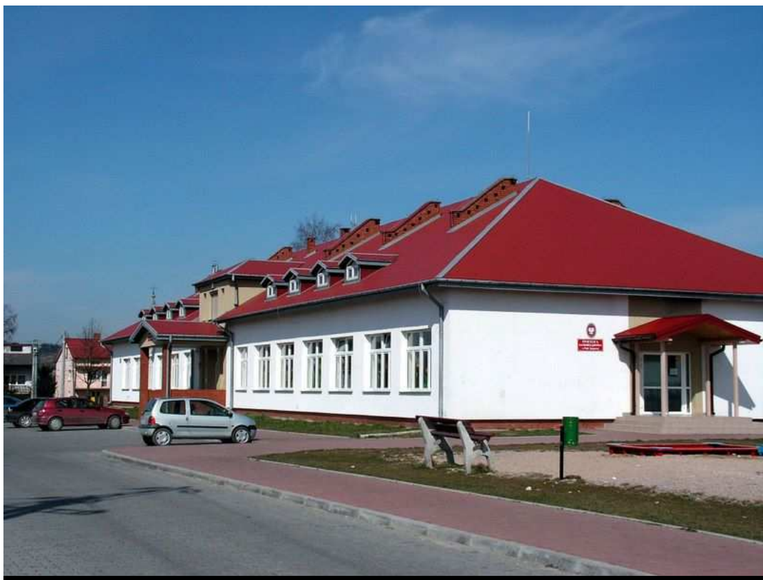
Fot. 5. Dom Ludowy w Woli Kopcowej
