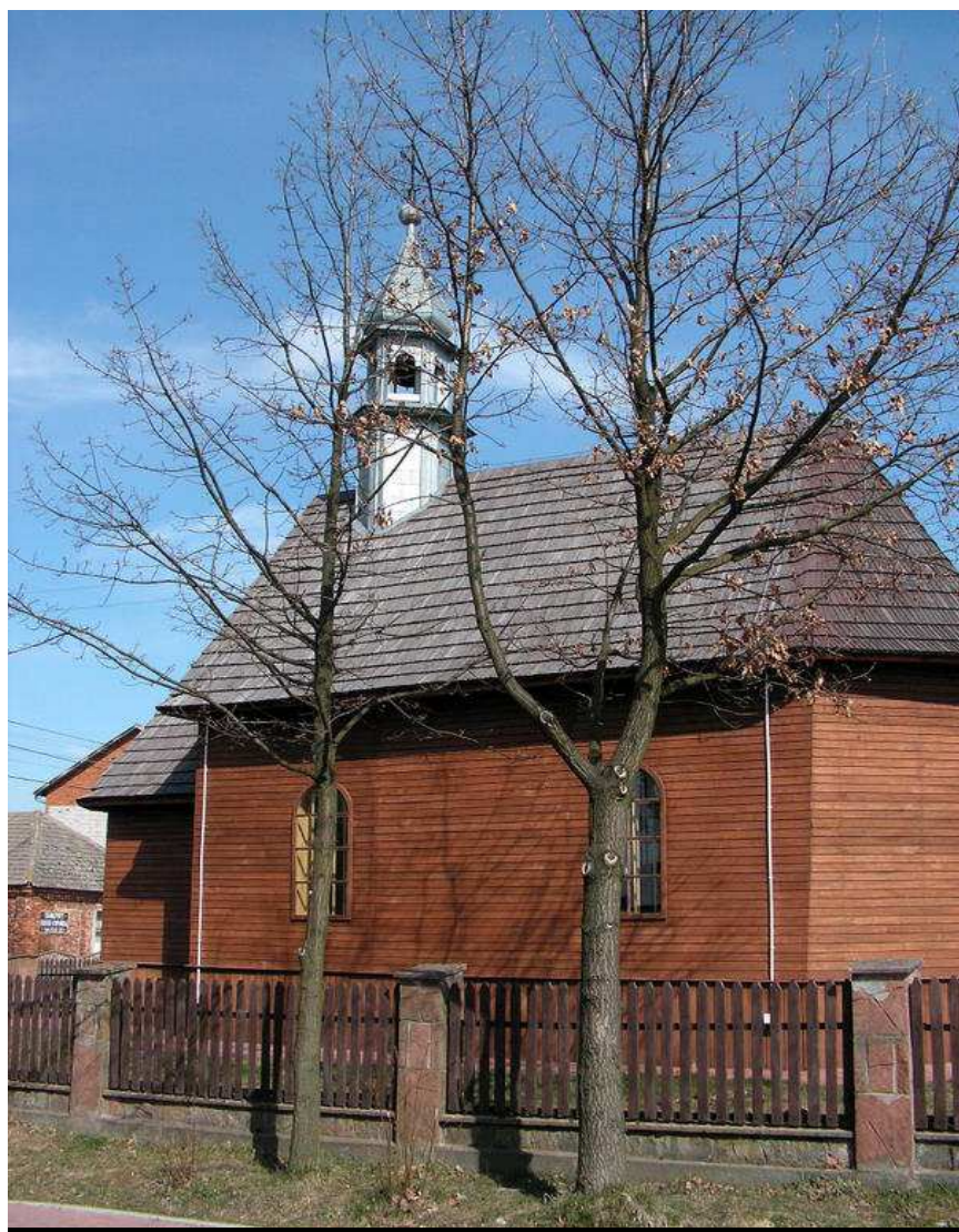
Fot. 2. XIX wieczna kaplica p.w. św. Józefa Robotnika przy ulicy Świętokrzyskiej
