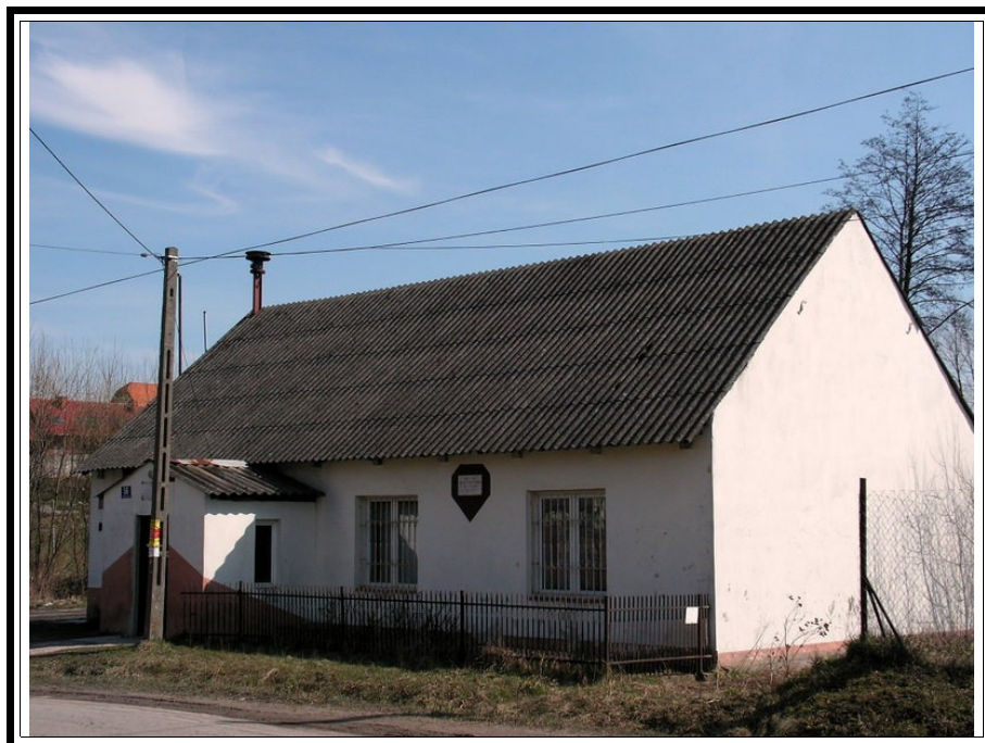
Budynek remizy OSP w Woli Kopcowej
