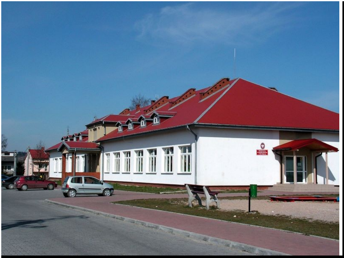
Fot. 5. Dom Ludowy w Woli Kopcowej
