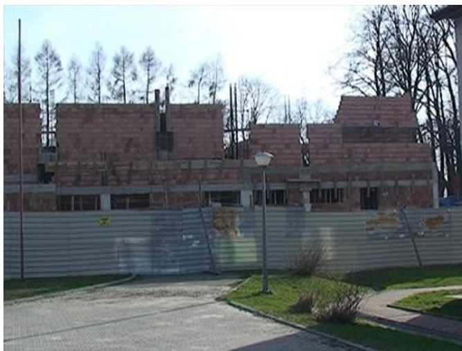
Rysunek 6. Budowa hali sportowej w Masłowie Pierwszym
