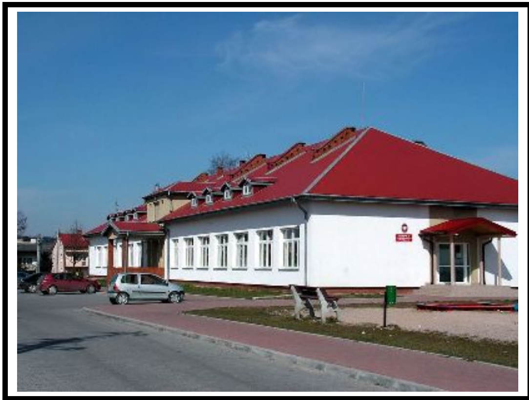
Fot. 5. Dom Ludowy w Woli Kopcowej
