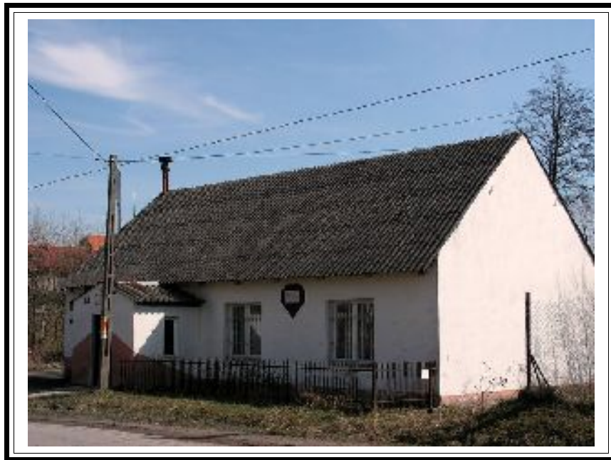
Budynek remizy OSP w Woli Kopcowej
