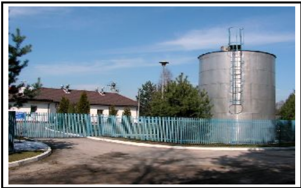
Fot. 1. Ujęcie wody w Woli Kopcowej
