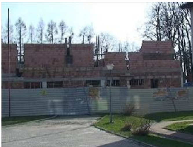
Rysunek 6. Budowa hali sportowej w Masłowie Pierwszym
