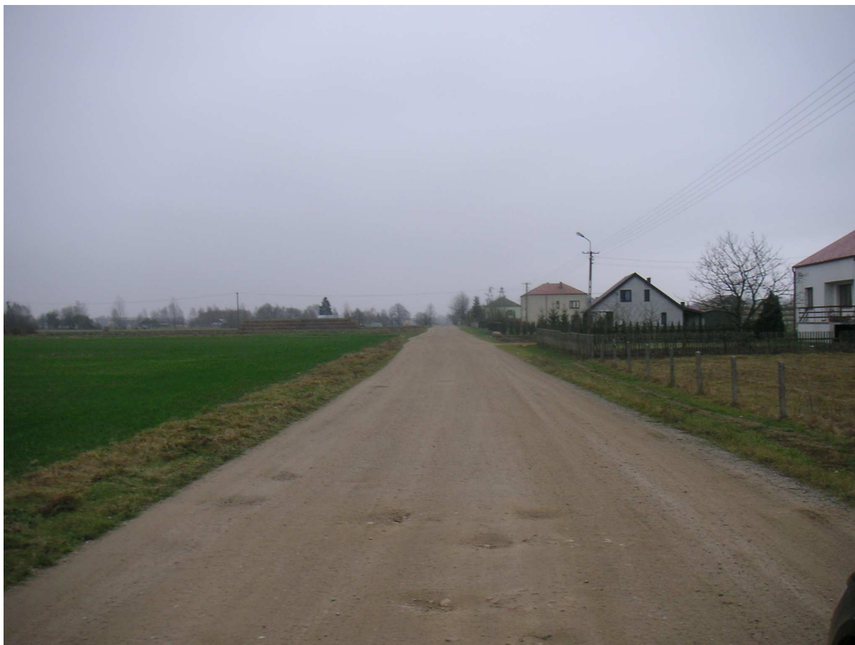
Fot 1. Widok drogi gminnej nr 100145L w kierunku południowo-wschodnim
