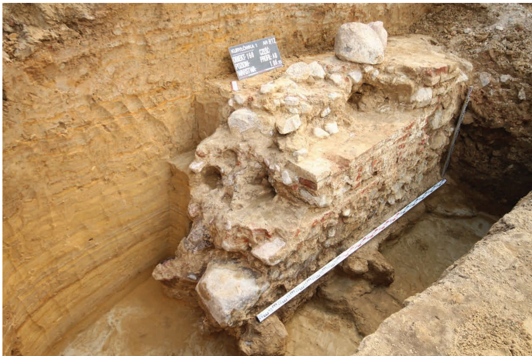
Fot. 7. Pozostałości południowego fundamentu oficyny przypałacowej z widocznym ceglany licem i kamiennym wypełnieniem.
