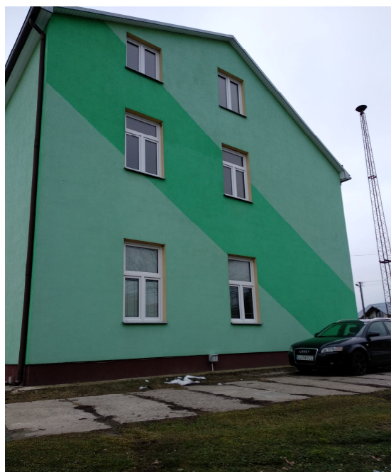
Fot. 2. Elewacja budynku
