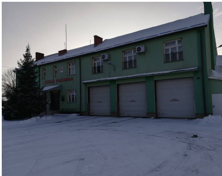
Fot. 4. Elewacja budynku
