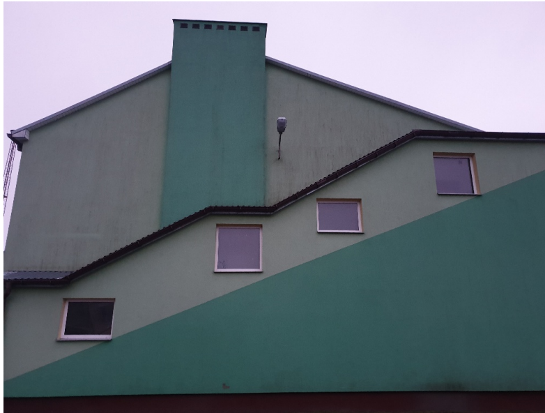
Fot. 3. Elewacja budynku
