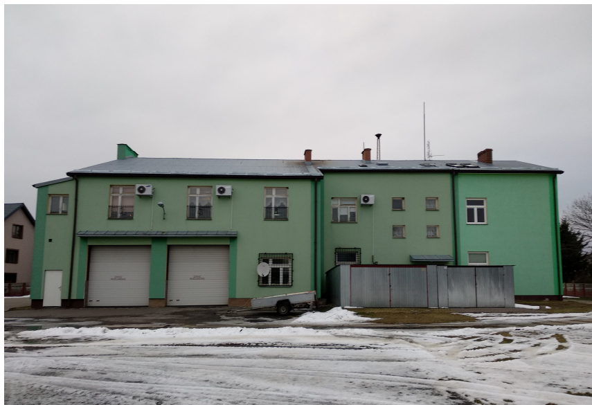
Fot. 1. Elewacja budynku
