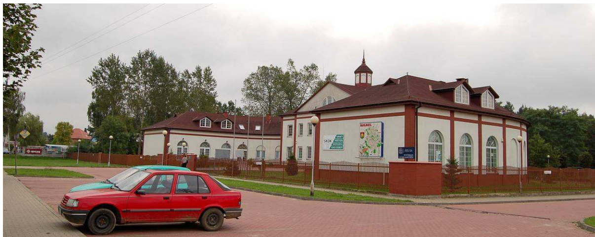
Zdjęcie 13. Budynek Urzędu Gminy w Kołbieli.
