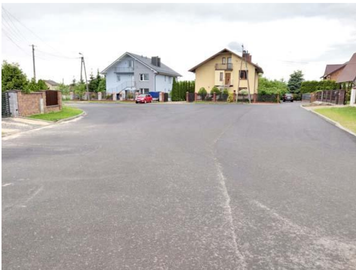
3. Nowo wybudowana droga na Osiedlu Leśnym (Plac Słoneczny).
