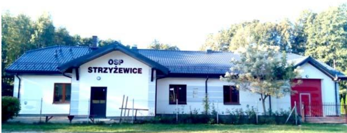
6. Rozbudowa i przebudowa budynku OSP w Strzyżewicach
