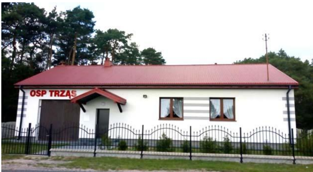
4. Modernizacja budynku OSP w miejscowości Trząs
