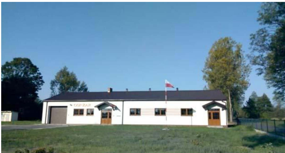
5. Przebudowa budynku w miejscowości Żar
