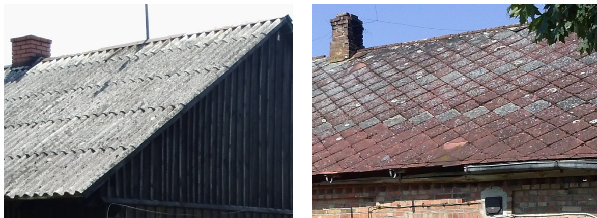
Rys. 1. Wyroby azbestowo – cementowe: po lewej płyty faliste, po prawej płaskie. (źródło: materiały własne)
