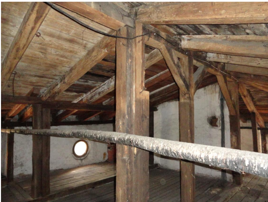
Fot.8. Wieżba dachowa w części prawej.
