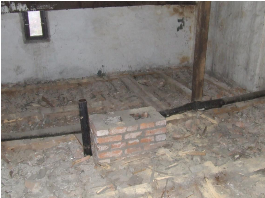
Fot.26. Strop nad 1 piętrem w części lewej
