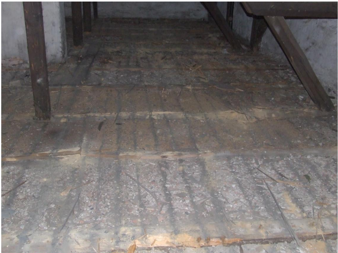
Fot.25. Strop nad 1 piętrzem w części lewej.
