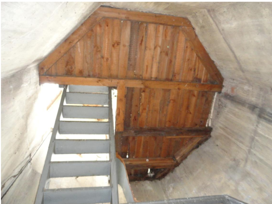
Fot.11. Strop wieży.
