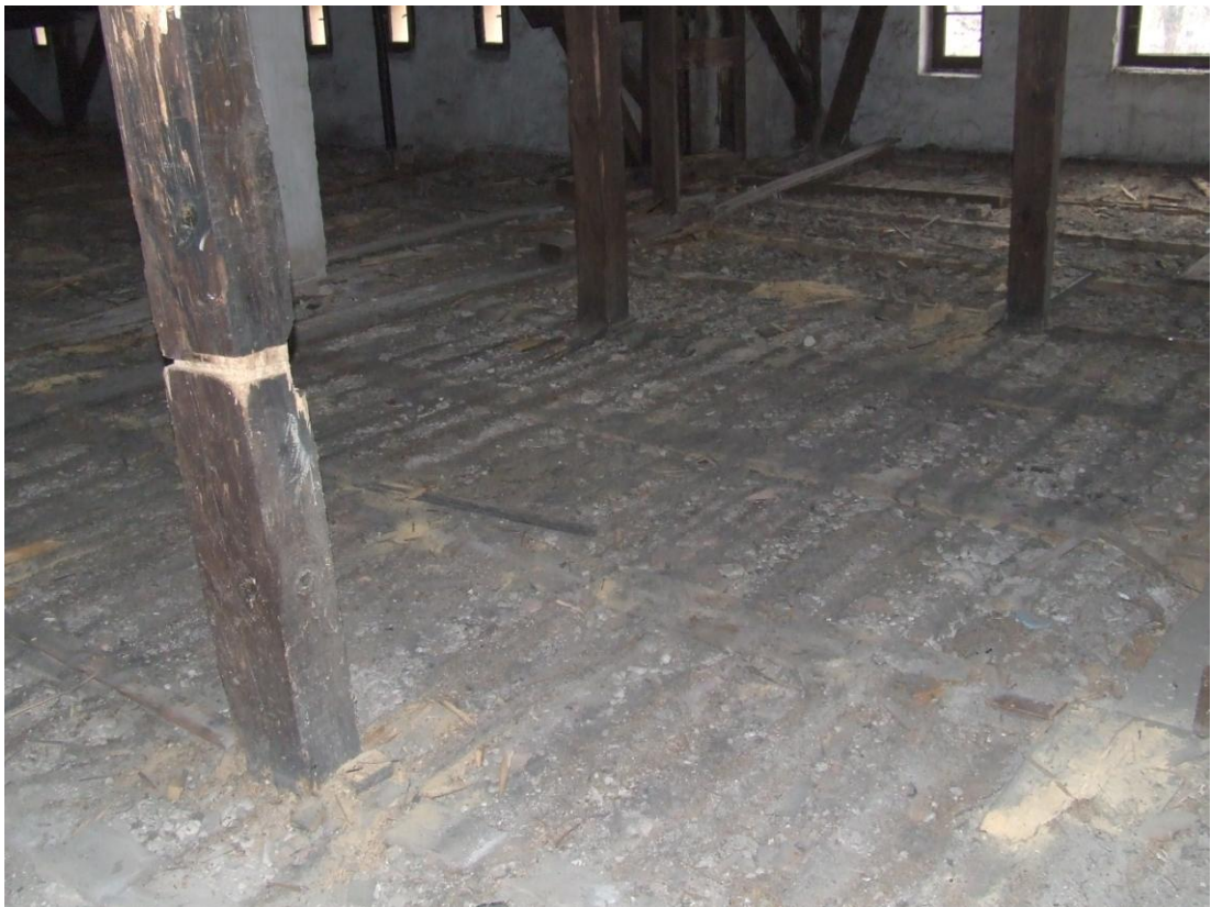
Fot.23. Strop nad 1 piętrem w części środkowej.
