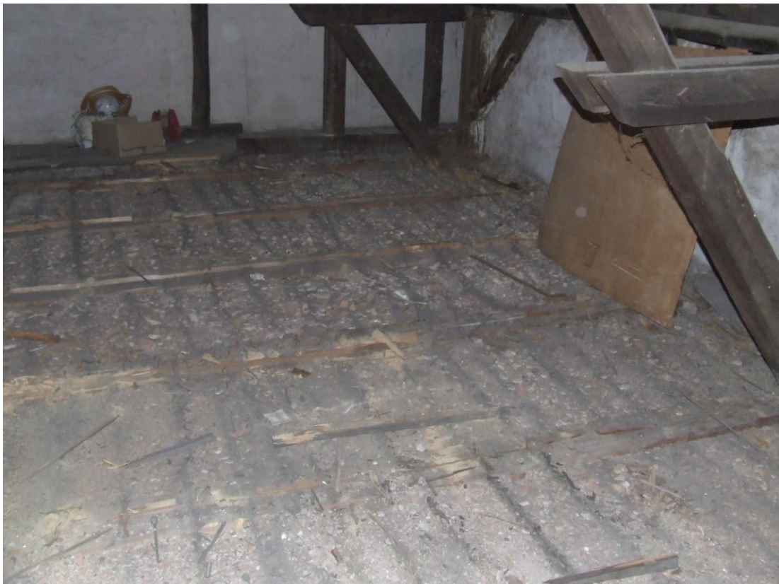
Fot.27. Strop nad 1 piętrem w części lewej.
