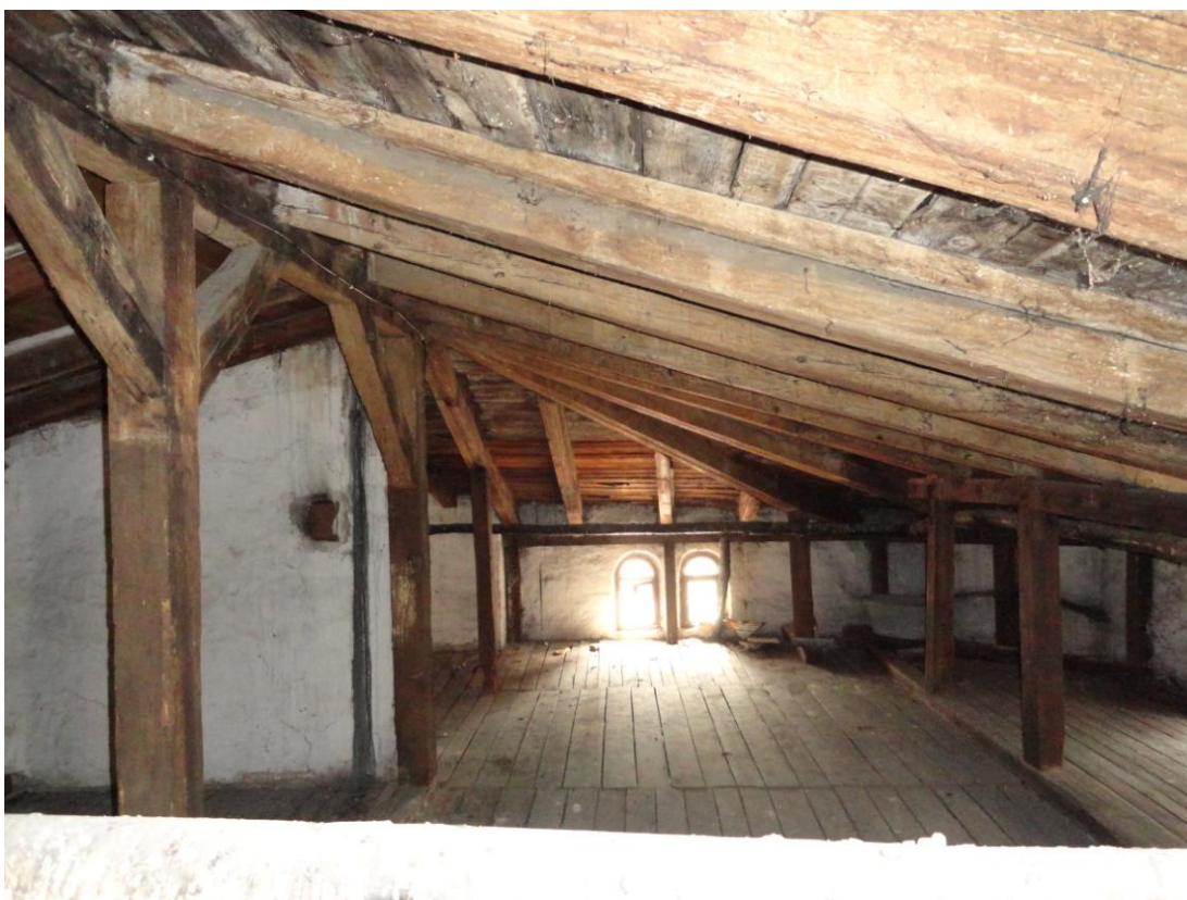
Fot.9. Wieżba dachowa w części prawej.
