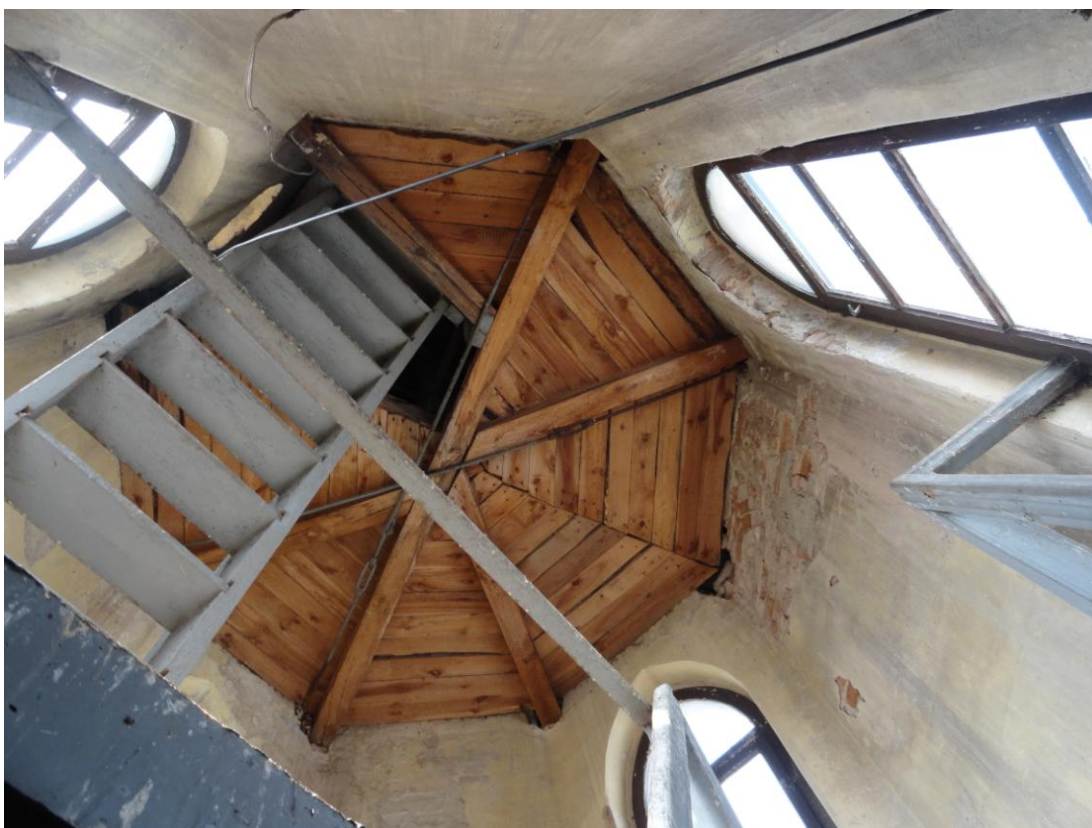
Fot.13. Strop wieży - podpora konstrukcji dachu wieży.
