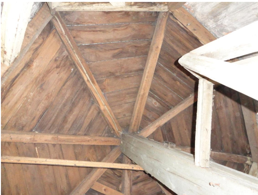
Fot.14. Strop wieży - poddasze nieużytkowe.
