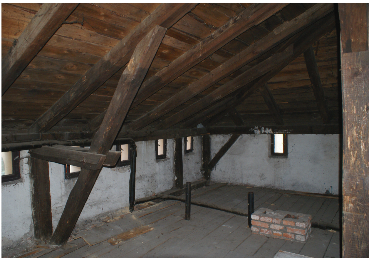
Fot.3 – Kaźmierz , pałac – konstrukcja dachowa , kleszcze dolne umieszczone pod płatwią obejmują zastrzał i słupek ramki ścianki kolankowej .
