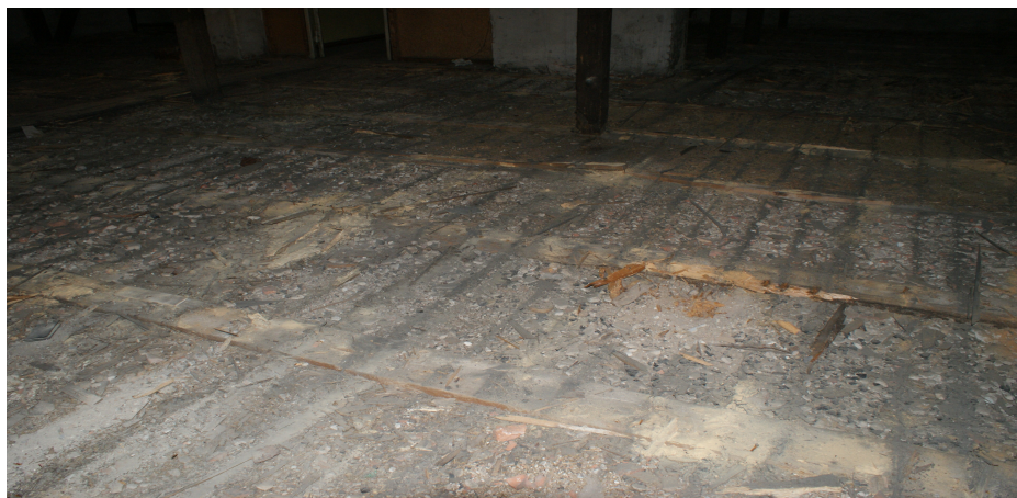
Fot.8 - Kaźmierz , pałac – poddasze, belki stropowe, aktywne żerowiska technicznych szkodników drewna.
