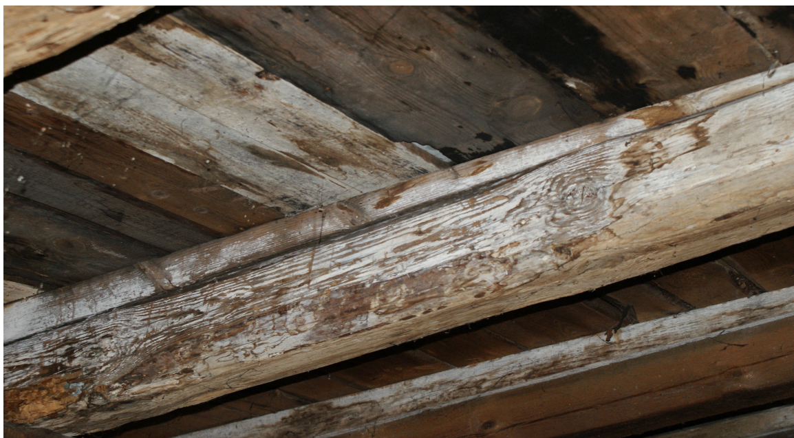
Fot. 4 Kaźmierz , pałac – konstrukcja dachowa , długie kliny wyrównujące spadek połaci dachu.
