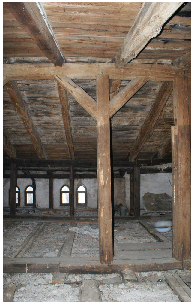
Fot. 6 Kaźmierz , pałac – zachowane fragm oryginalnej więźby.
