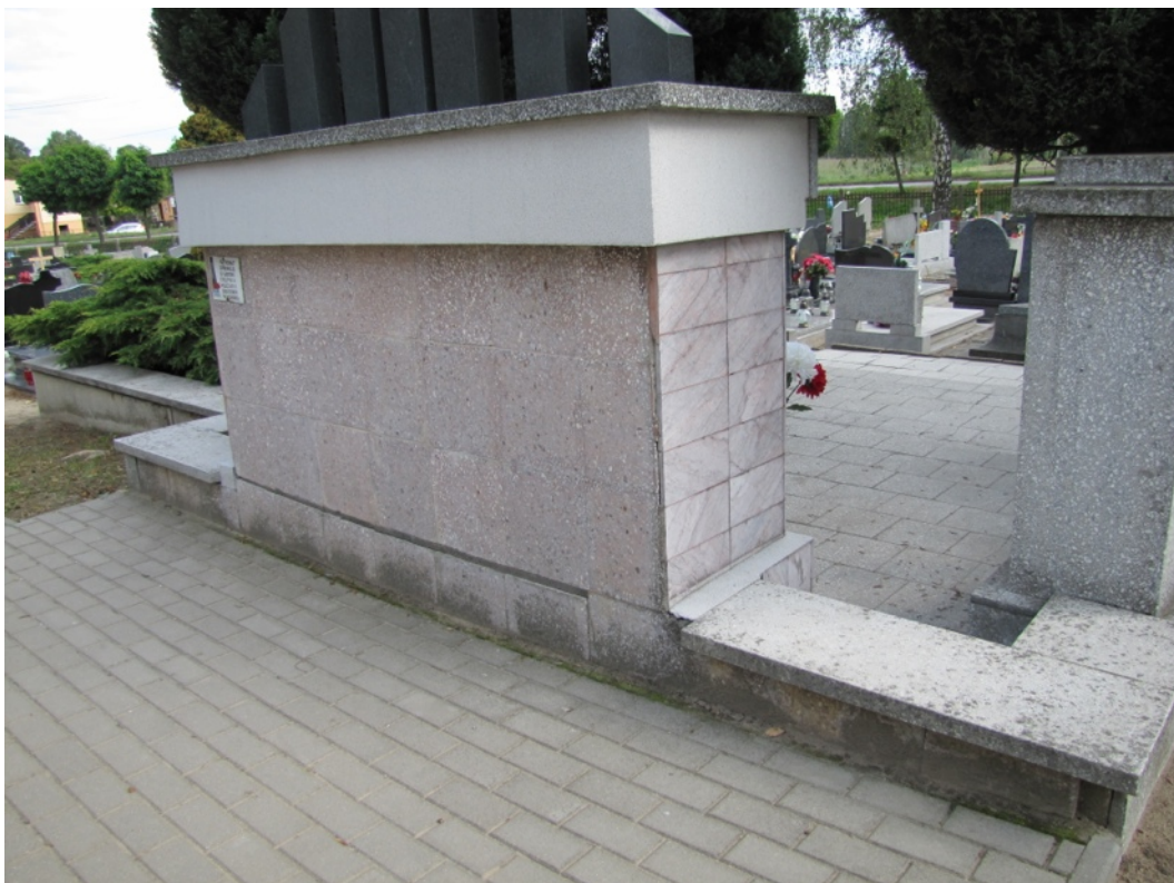
Fot. 2 Tył pomnika. Widoczna okładzina lastriko oraz obramienie ze styropianu pokrytego tynkiem marmurkowym, które należy usunąć.
