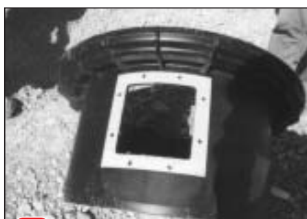
5 Zamocowanie stopnia przygotowane do montażu
