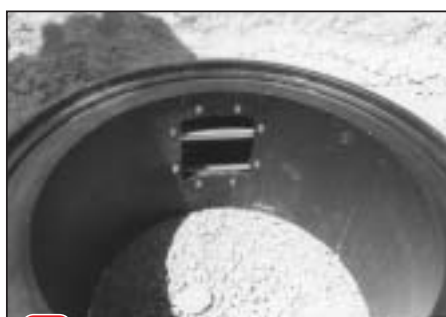
8 Nasada wyposażona w stopień złazowy
