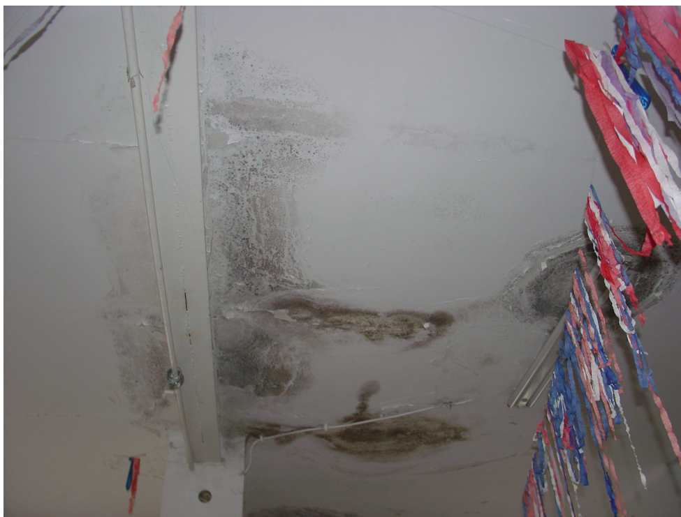
Liczne plamy zawilgocenia widoczne na stropie spowodowane nieuszczelnieniem pokrycia dachu
