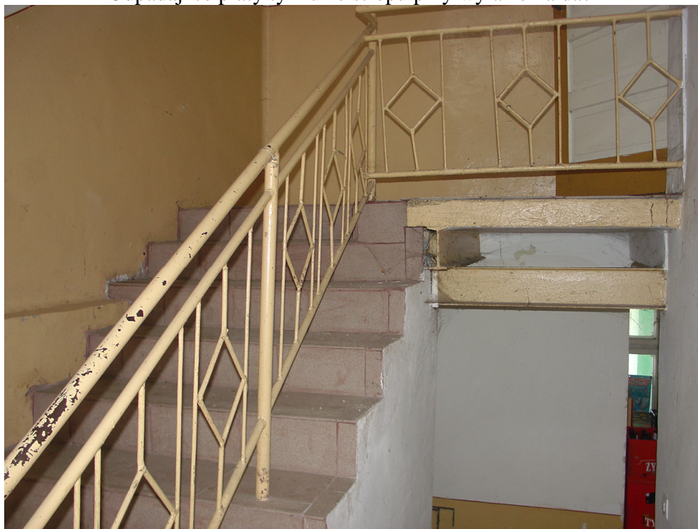
Widok ogólny klatki schodowej
