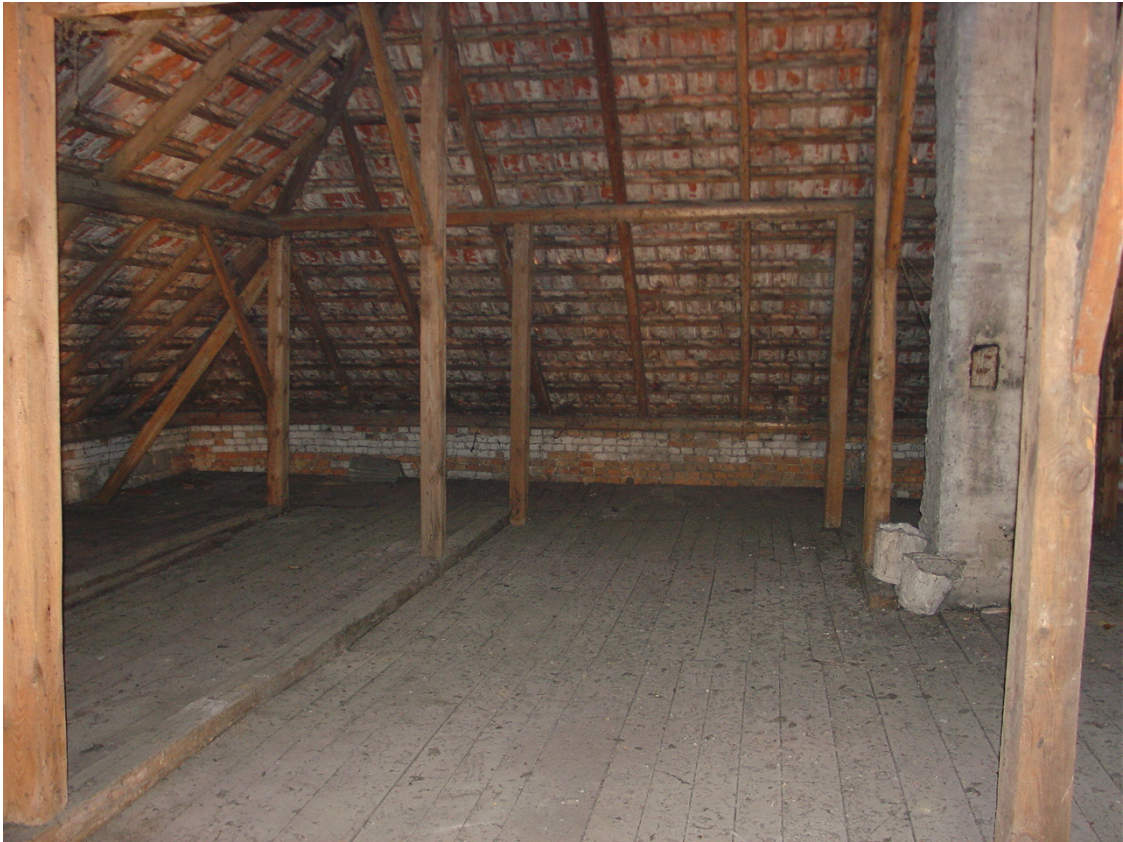
Widok strychu – konstrukcja dachu
