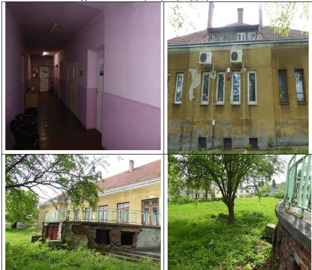
Zdjęcie 17 Stan aktualny budynku po byłym przedszkolu
