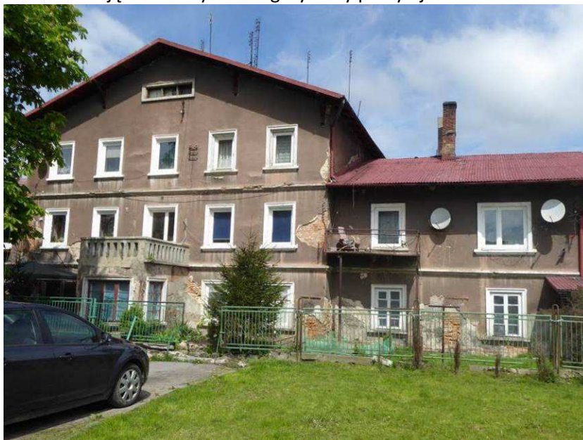
Zdjęcie 7 Budynek magazynowy po byłej cukrowni
