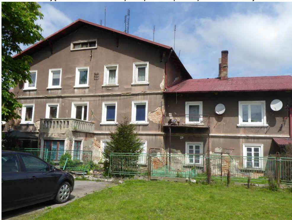
Zdjęcie 18 Stan aktualny budynku Wspólnoty Mieszkaniowej
