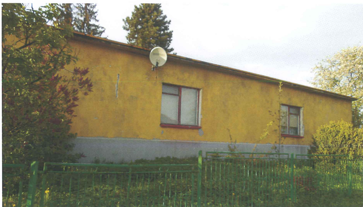
Elewacja południowa - widok ogólny
