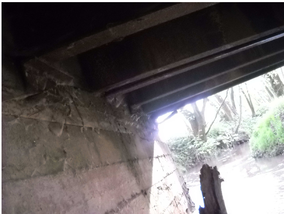
FOT. 10 Widok mostu od dołu na mocowanie belek
