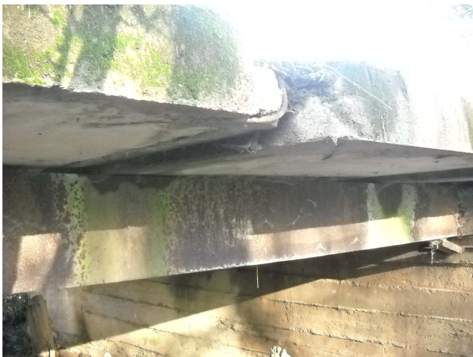
FOT. 9 Widok mostu od dołu na 3 płyty mostu
