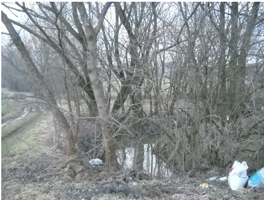
FOT. 12 Widok mostu od góry na pobocze i skarpy – str. prawa
