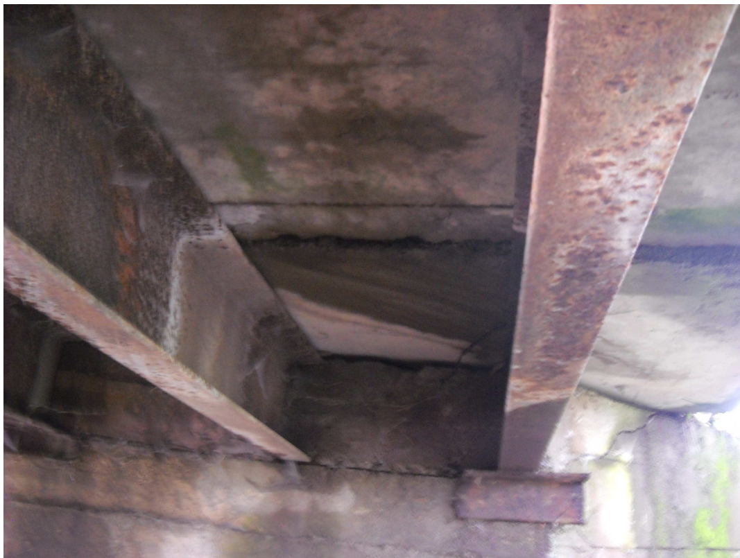
FOT. 7 Konstrukcja nośna mostu (belki nośne , ceowniki 300mm)
