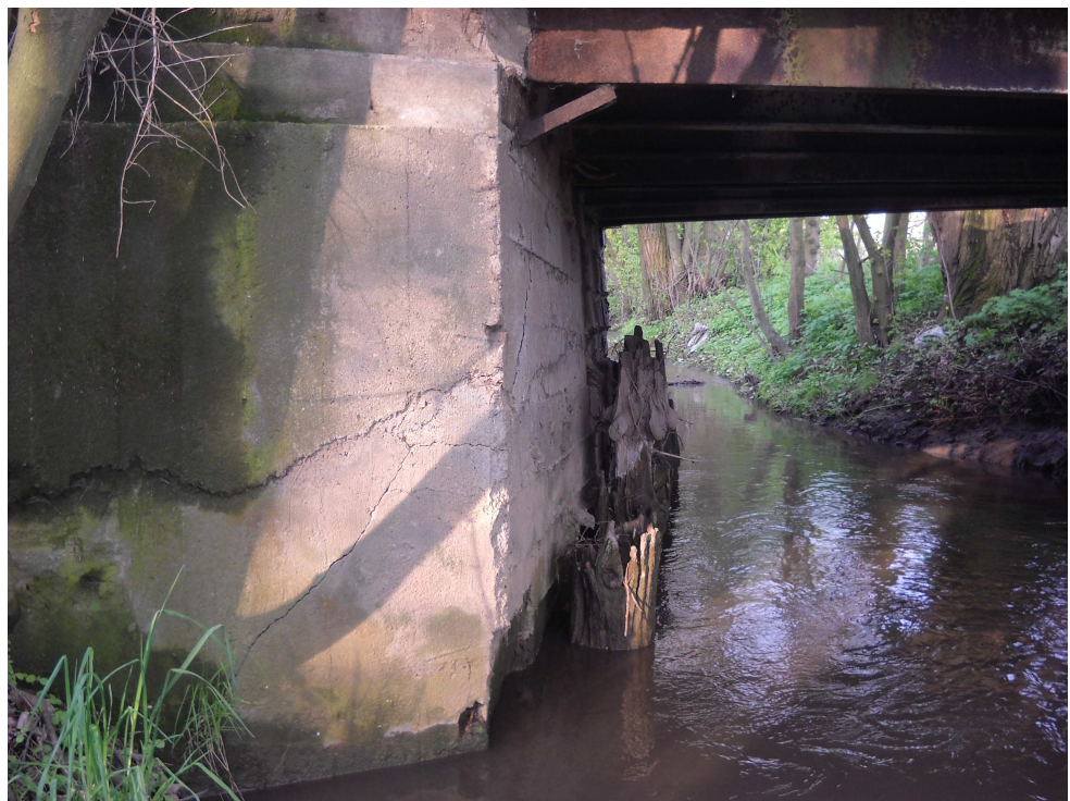
FOT. 4 Lewy przyczółek mostu
