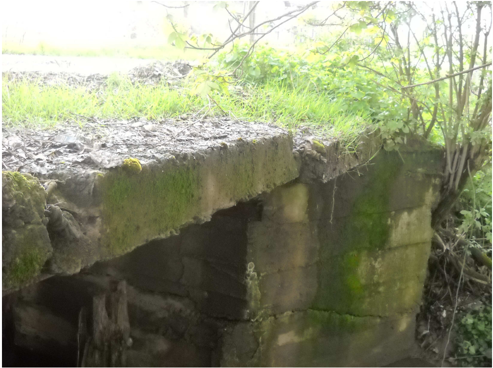
FOT. 3 Prawy przyczółek mostu
