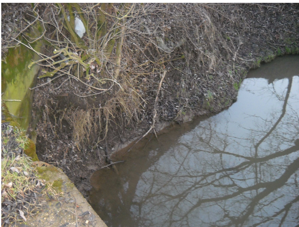
FOT. 2 Widok powyżej mostu
