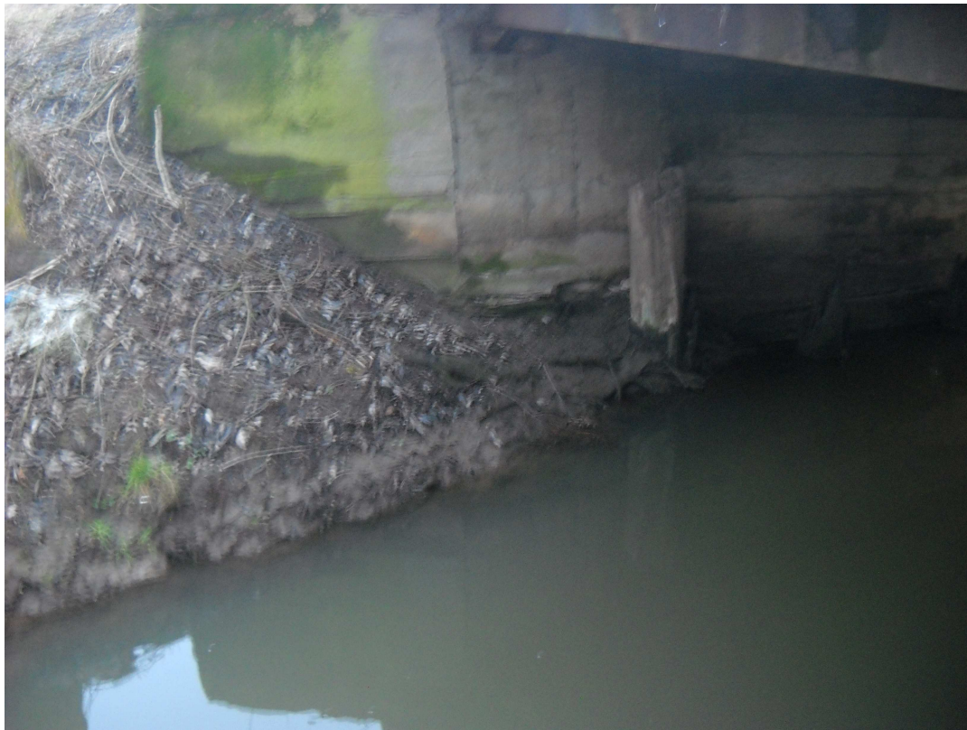
FOT. 13 Widok mostu od góry na skarpy i dno
