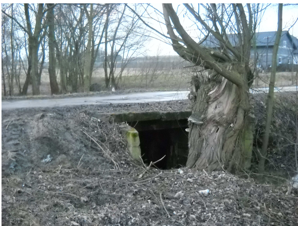
FOT. 12 Widok mostu od góry na pobocze i skarpy – str. lewa
