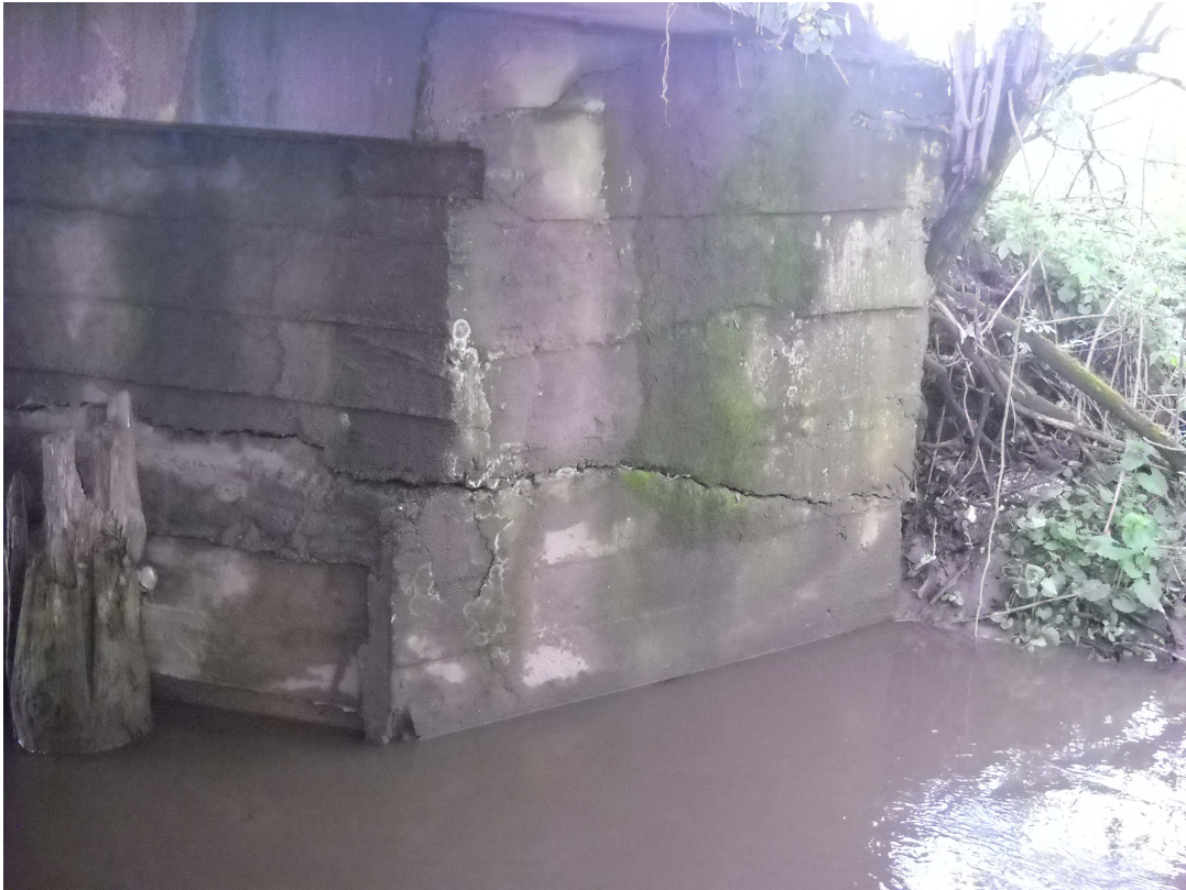
FOT. 5 Brzeg rzeki powyżej mostu strona lewa
