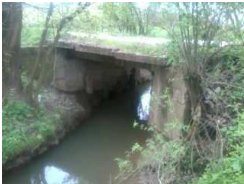
FOT. 1 Widok poniżej mostu
