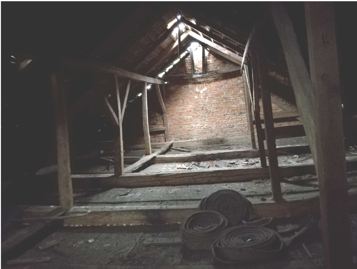
Fot 2 Widok konstrukcji dachu budynku
