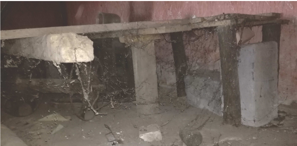
Fot 4 Widok konstrukcji podłogi
