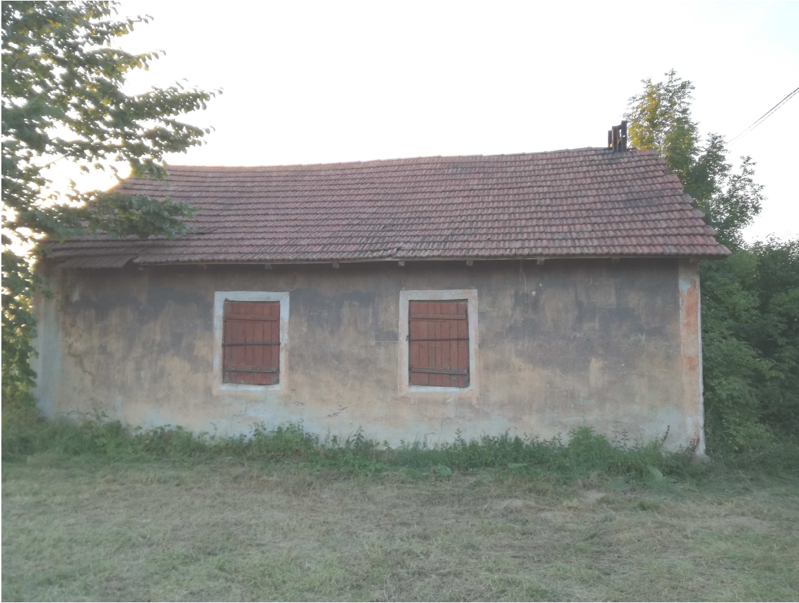
Fot 1 Elewacja północna budynku
