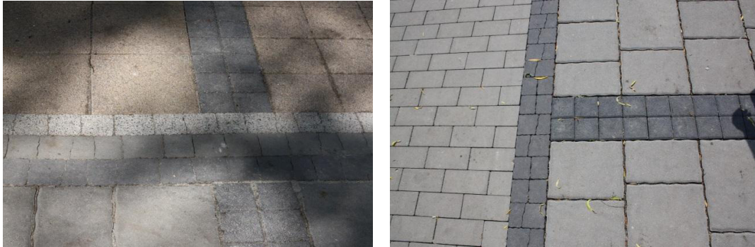
Nawierzchnia z kostek i płytek betonowych - projekt Studio-MK
