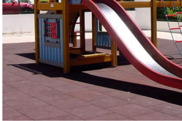
Nawierzchnia syntetyczna z płytek.
