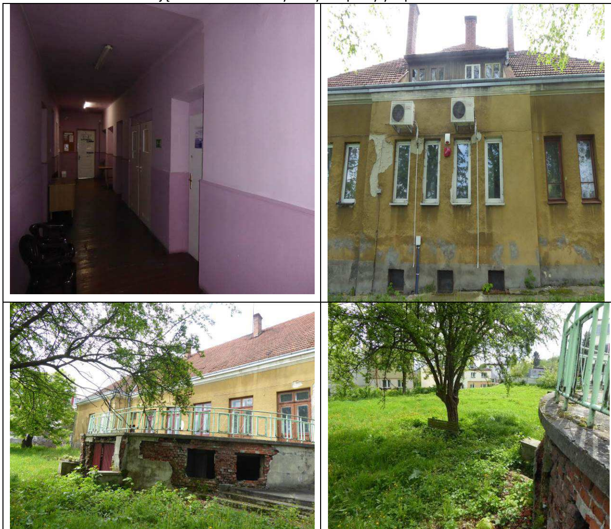
Zdjęcie 17 Stan aktualny budynku po byłym przedszkolu
