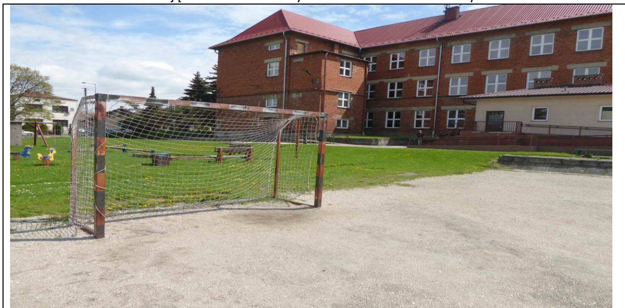
Zdjęcie 13 Stan aktualny boiska oraz otoczenia szkoły
