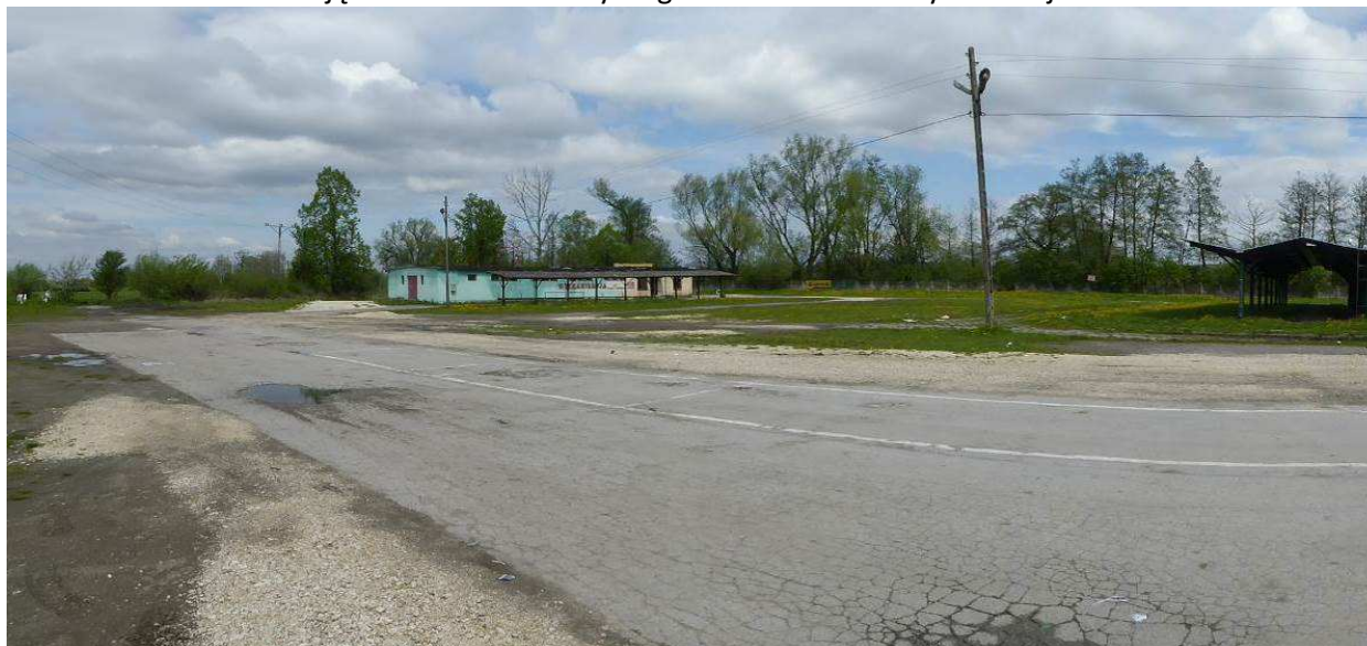
Zdjęcie 16 Stan aktualny targowiska w Kazimierzy Wielkiej
