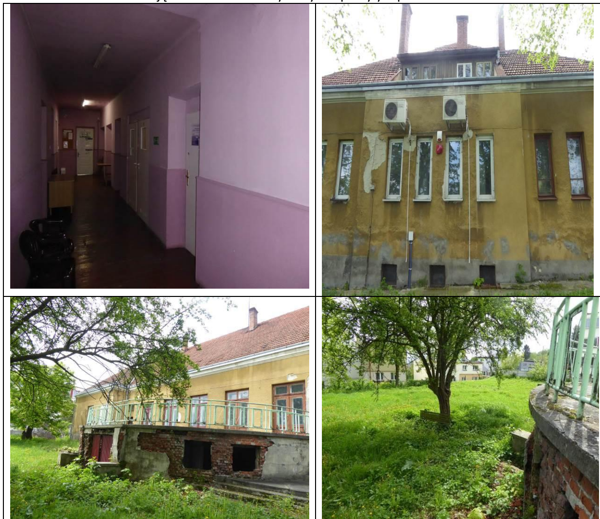
Zdjęcie 17 Stan aktualny budynku po byłym przedszkolu
