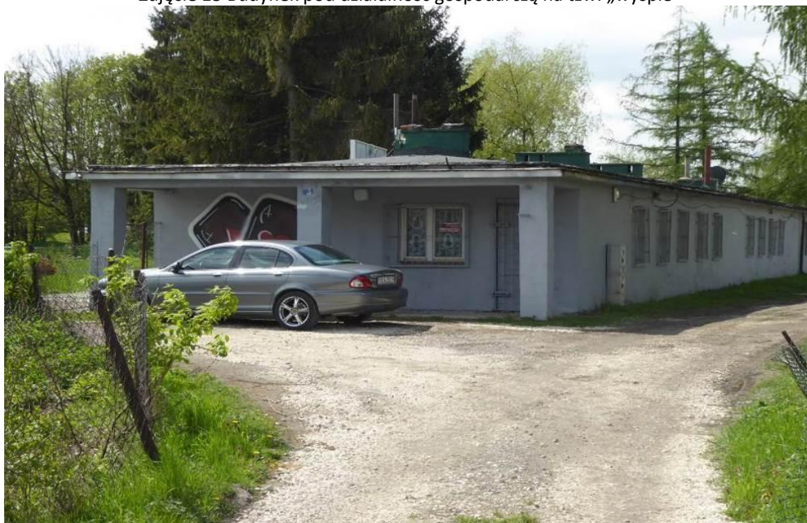
Zdjęcie 15 Budynek pod działalność gospodarczą na tzw. „wyspie”
