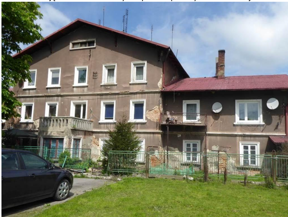
Zdjęcie 18 Stan aktualny budynku Wspólnoty Mieszkaniowej
