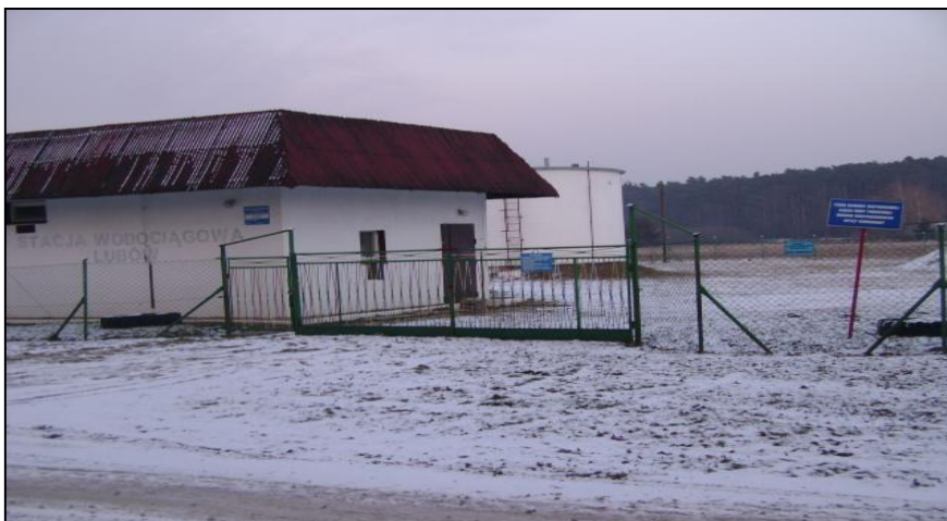
Zdjęcie nr 12: Stacja wodociągowa w Lubowie.
