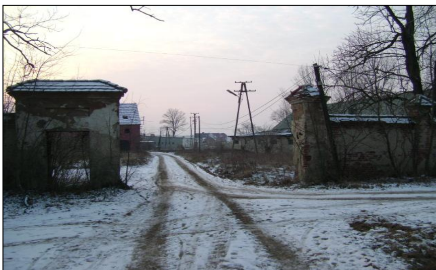
Zdjęcie nr 4: Brama wjazdowa do folwarku.
