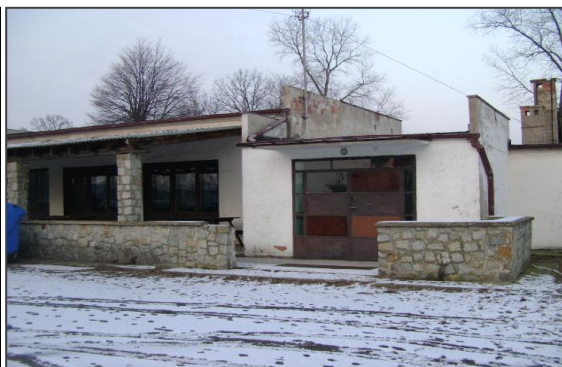
Zdjęcie nr 19: Świetlica wiejska.
