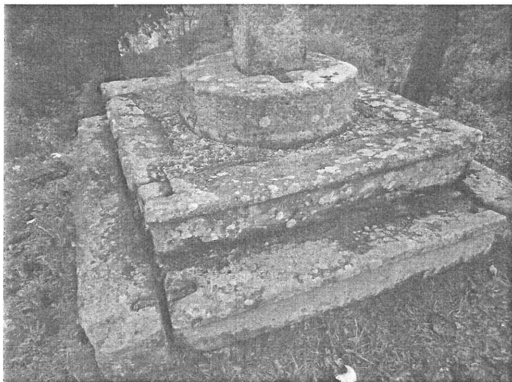
Kapliczka słupowa w Jaśliskach, podstawa fot., ze zbiorów Urzędu Gminy w Jaśliskach
