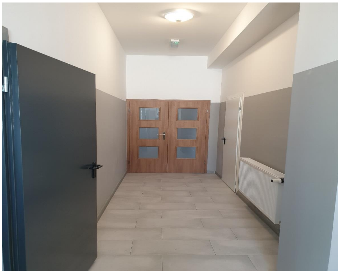
Fot. 4.24. Modernizacja i remont pomieszczeń budynku OSP w Jabłonowie Pomorskim (źródło: UMiG Jabłonowo Pomorskie)
