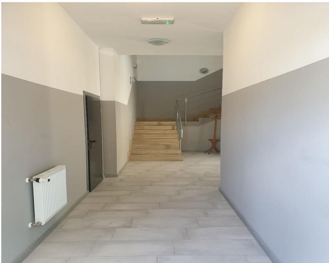
Fot. 4.22. Modernizacja i remont pomieszczeń budynku OSP w Jabłonowie Pomorskim (źródło: UMiG Jabłonowo Pomorskie)
