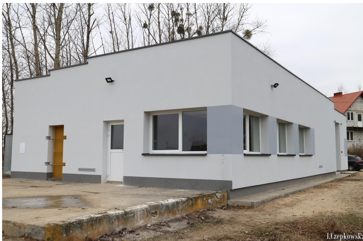
Fot. 4.20. Rozbudowa budynku użyteczności publicznej (świetlica w Nowej Wsi) wraz z jego przebudową i termomodernizacją (źródło: UMiG Jabłonowo Pomorskie)
