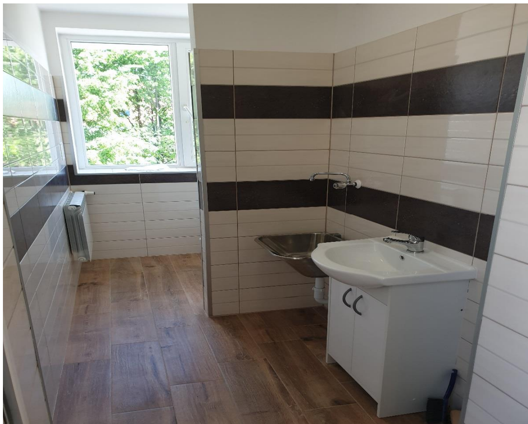
Fot. 4.23. Modernizacja i remont pomieszczeń budynku OSP w Jabłonowie Pomorskim (źródło: UMiG Jabłonowo Pomorskie)
