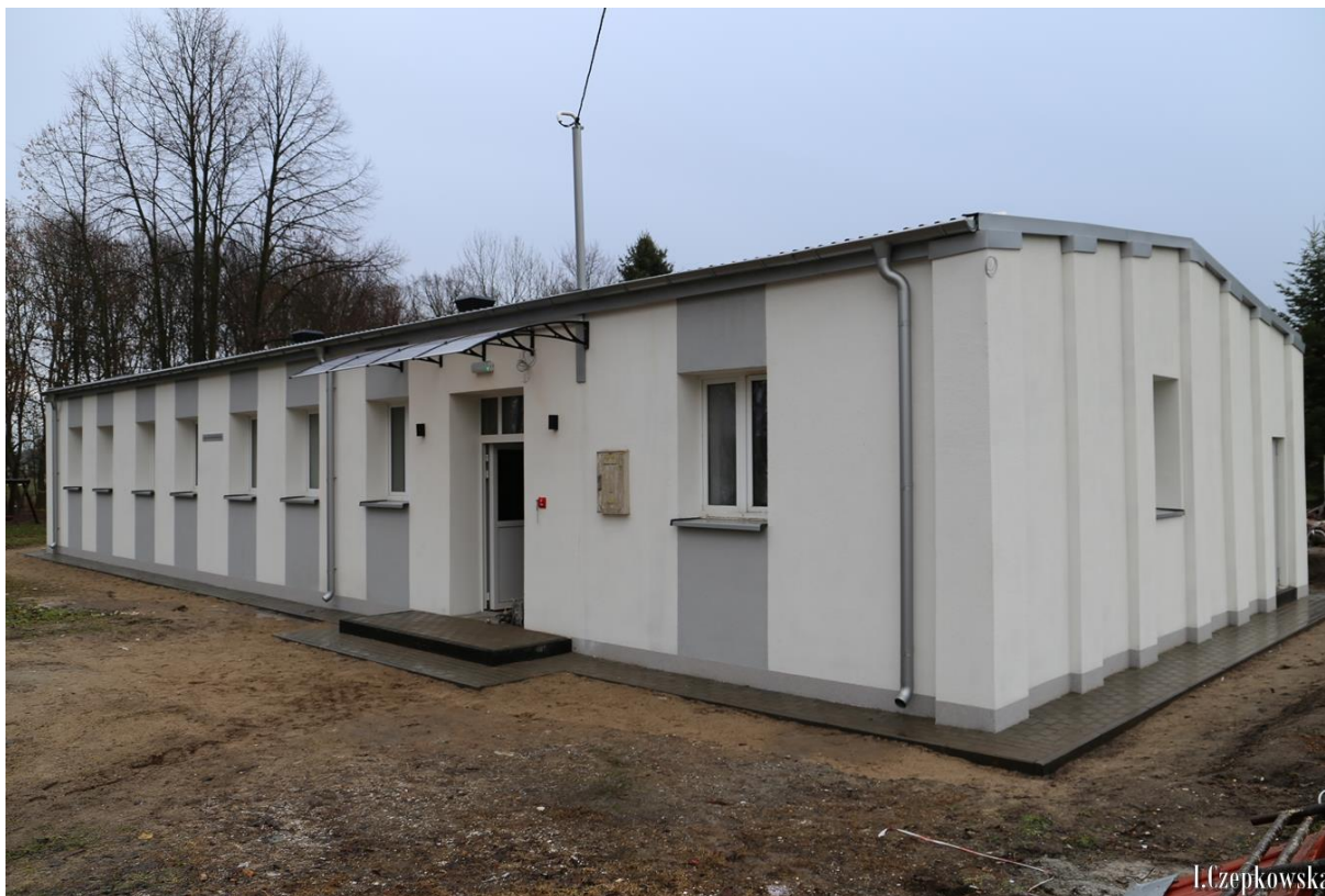
Fot. 4.17. Zmiana sposobu użytkowania części budynku użyteczności publicznej (świetlica w Lembargu) na pomieszczenia techniczne (kotłownię) wraz z jego przebudową i termomodernizacją (źródło: UMiG Jabłonowo Pomorskie)
