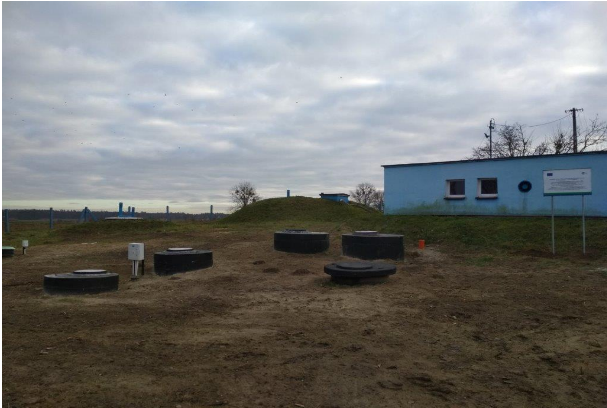
Fot. 4.21. Przebudowa stacji uzdatniania wody w miejscowości Górale (źródło: UMiG Jabłonowo Pomorskie)
