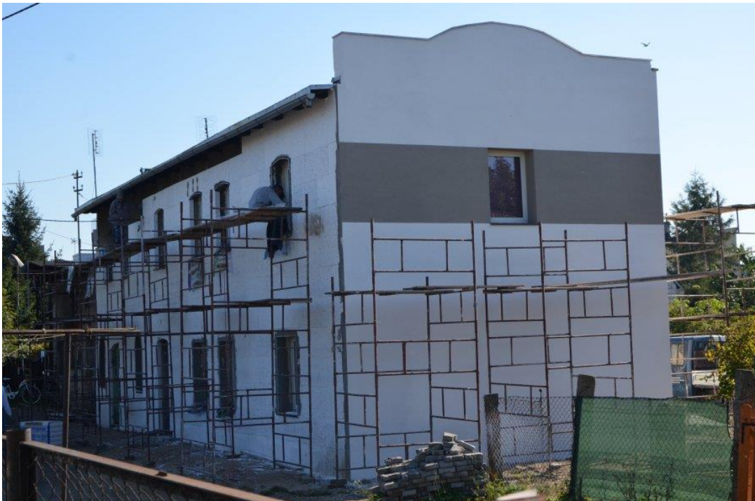
Fot. 6.5. Budynek w Jabłonowie Pomorskim przy ul Wigury 1 przed i po remoncie (źródło: UMiG Jabłonowo Pomorskie)
