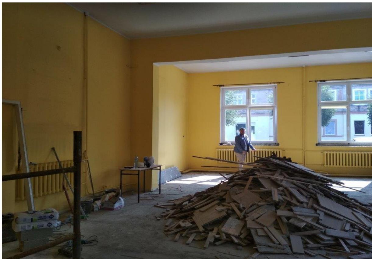
Fot. 5.4. Sala Klubu Seniora w czasie remontu (źródło: UMiG Jabłonowo Pomorskie)
