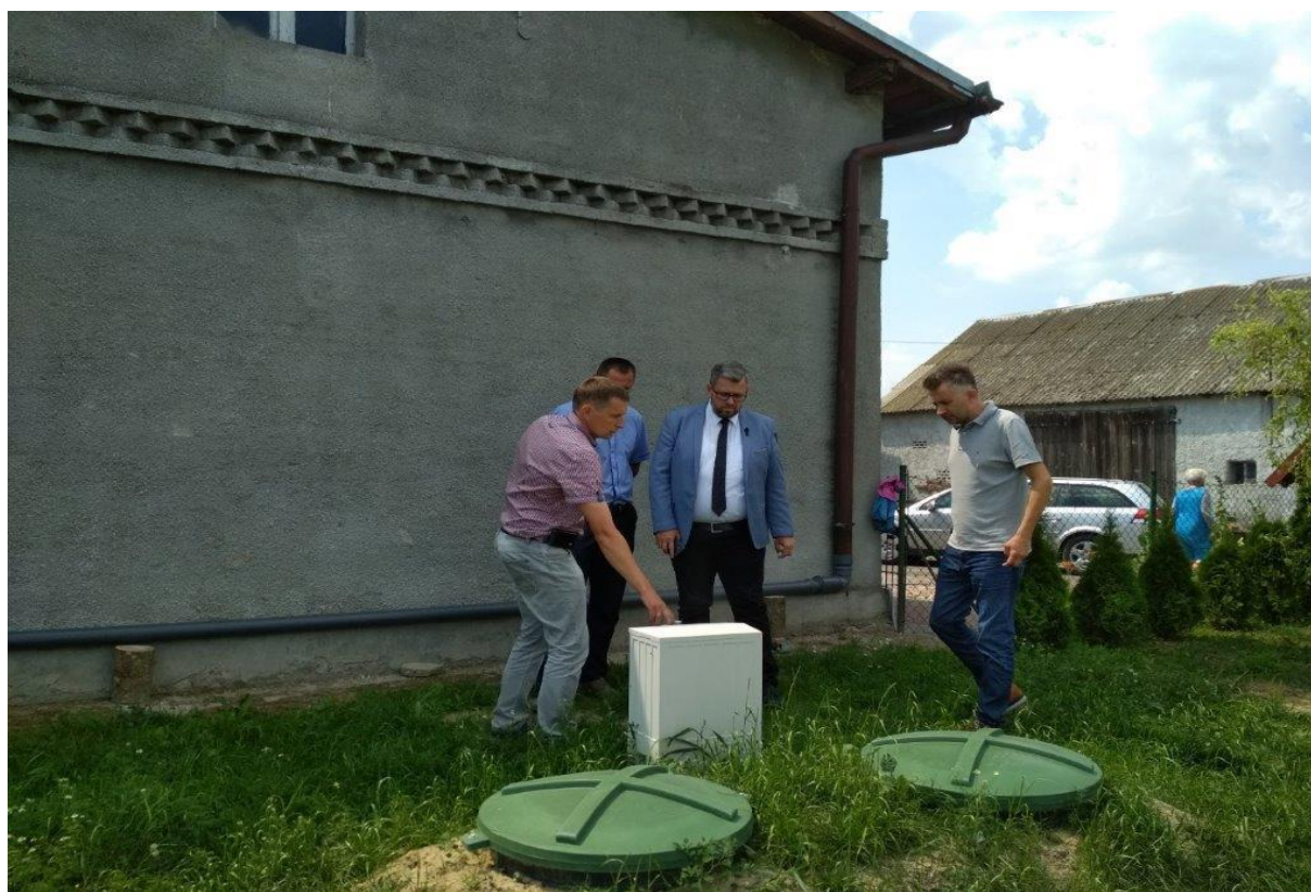
Fot. 4.8. Budowa przydomowych oczyszczalni ścieków na terenie Miasta i Gminy Jabłonowo Pomorskie (źródło: UMiG Jabłonowo Pomorskie)
