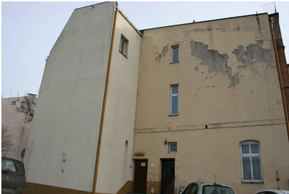
Fot. 6. Elewacja tylna.
