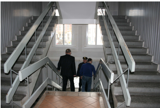
Fot. 9, 10. Klatka schodowa, holl – posadzka z lastriko (oprócz posadzki na I piętrze, gdzie jest nowa wierzchnia warstwa posadzki z płytek ceramicznych).
