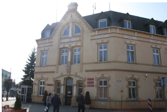
Fot. 1. Elewacja frontowa (narożna ulic Głównej i Mostowej).
