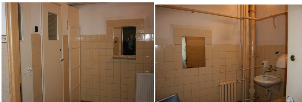
Fot. 12, 13, 14. Korytarz na pozostałych kondygnacjach – część nieodnowiona: zróżnicowane, zniszczone posadzki, zróżnicowane okładziny ścian i drzwi wewnętrzne, sufity z widocznymi instalacjami.
