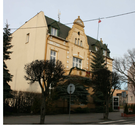
Fot. 4. Elewacja boczna (od ulicy Głównej).
