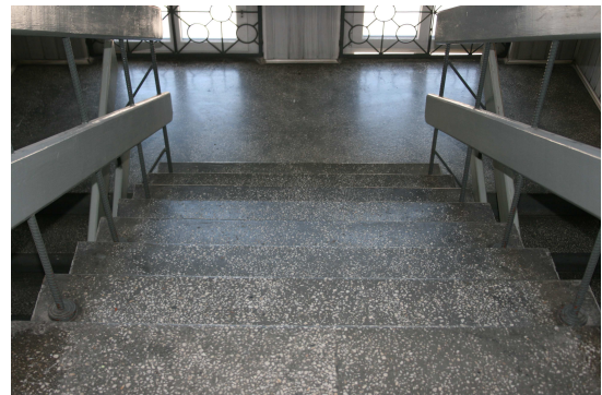
Fot. 9, 10. Klatka schodowa, holl – posadzka z lastriko (oprócz posadzki na I piętrze, gdzie jest nowa wierzchnia warstwa posadzki z płytek ceramicznych).
