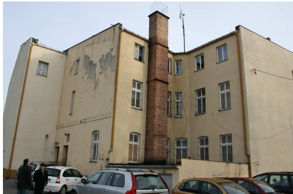
Fot. 5. Elewacja tylna.
