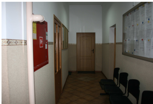
Fot. 11. Korytarz na I piętrze – część odnowiona: posadzka z płytek ceramicznych, ściany tynkowane, ujednolicone drzwi.
