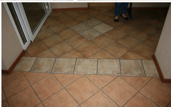
Fot. 19, 20, 21. Odnowiona posadzka - płytki ceramiczne na korytarzu I piętra.
