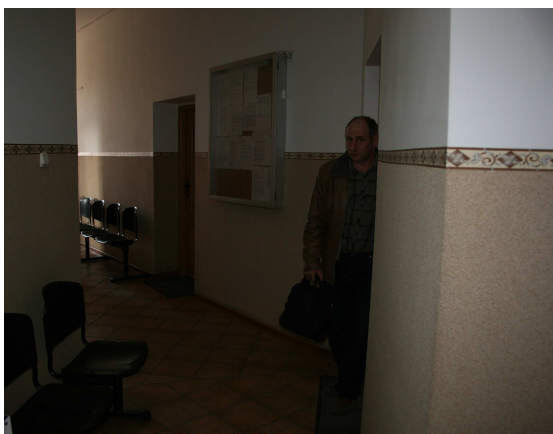
Fot.22, 23. Odnowione ściany – ściany tynkowane, z ozdobnym paskiem tapety, powyżej paska tapety ściana tynkowana z geometrycznym wzorem.
