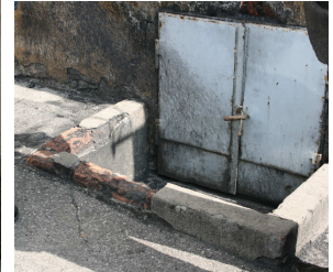
Fot. 8. Studzienka w elewacji.
