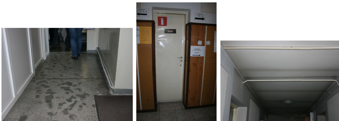
Fot. 12, 13, 14. Korytarz na pozostałych kondygnacjach – część nieodnowiona: zróżnicowane, zniszczone posadzki, zróżnicowane okładziny ścian i drzwi wewnętrzne, sufity z widocznymi instalacjami.
