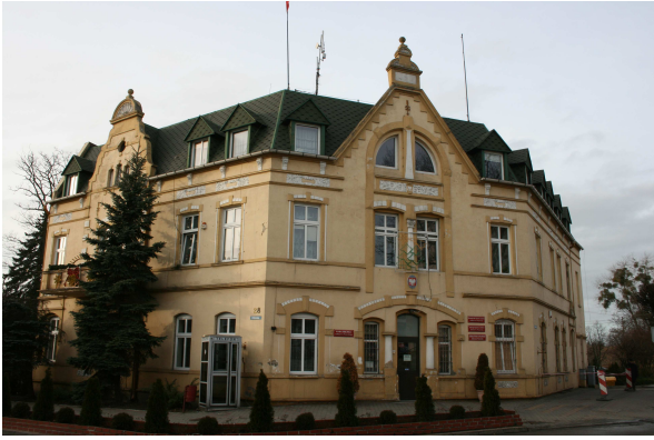
Fot. 3. Elewacja frontowa (narożna ulic Głównej i Mostowej).
