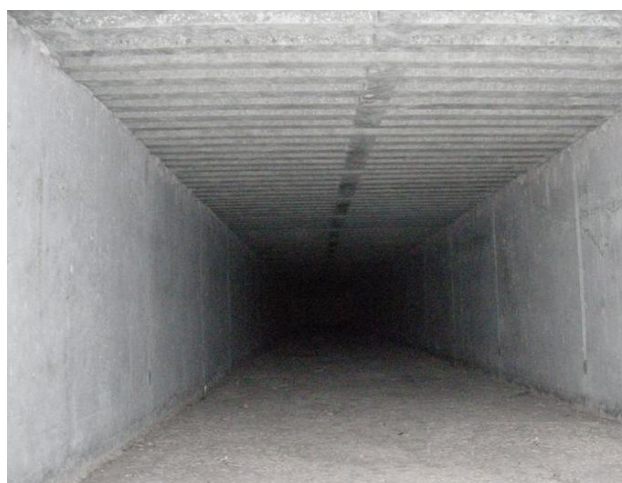
Rys. 5 Kanał pod korytarzem kontrolnym
