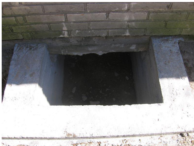
Rys. 4 Otwór w ścianie fundamentowej
