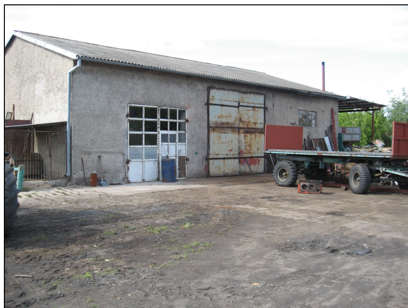
Hala stacji demontażu
