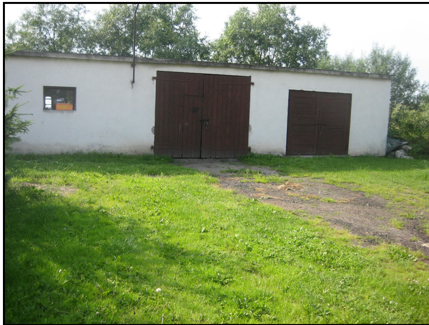
Budynek hali stacji demontażu
