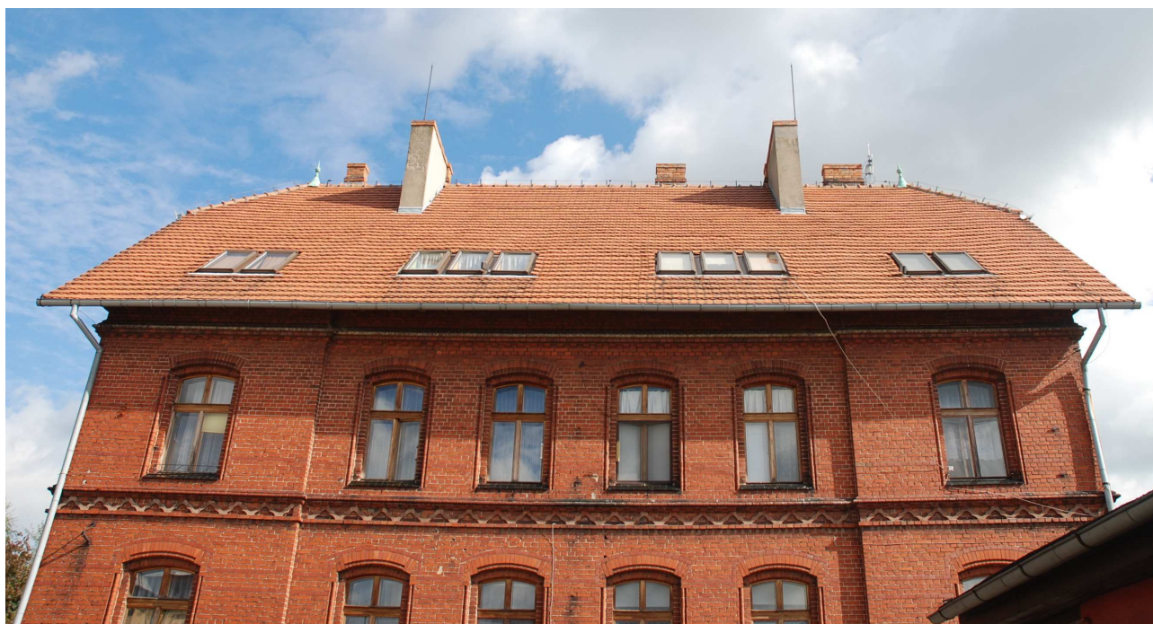
Fot. 2. Widok budynku od strony zachodniej
