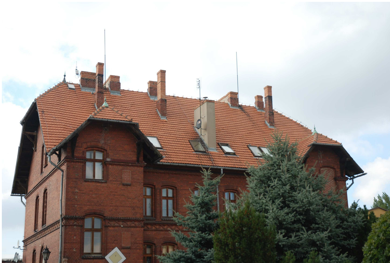
Fot. 1. Widok budynku od strony wschodniej
