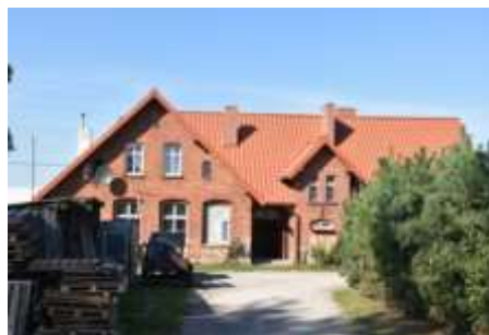
Fot. 28. Morawy, dawna szkoła, ob. budynek mieszkalny.
