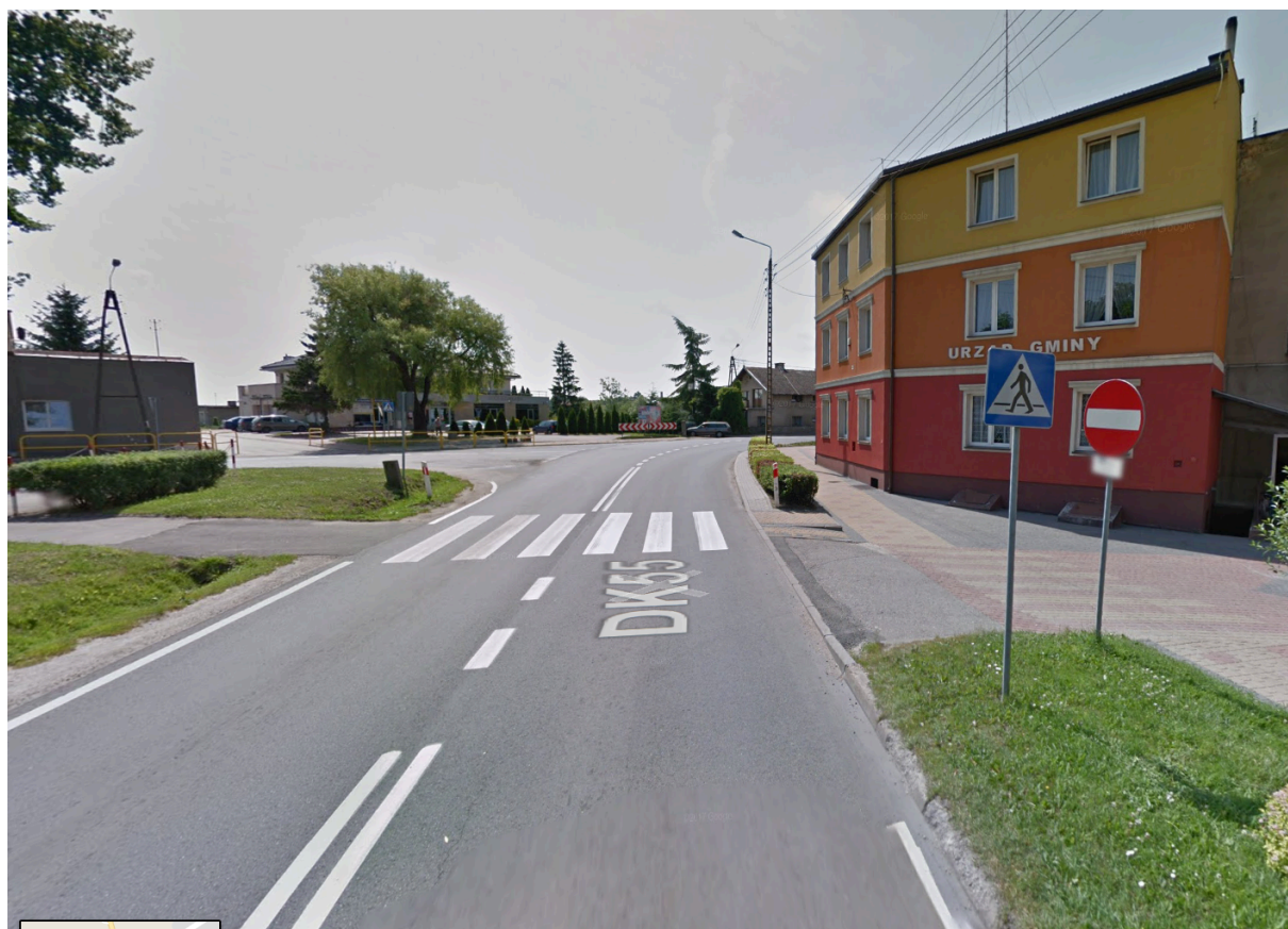
Zdjęcie 1. Droga krajowa nr 55 – miejscowość Gardeja
