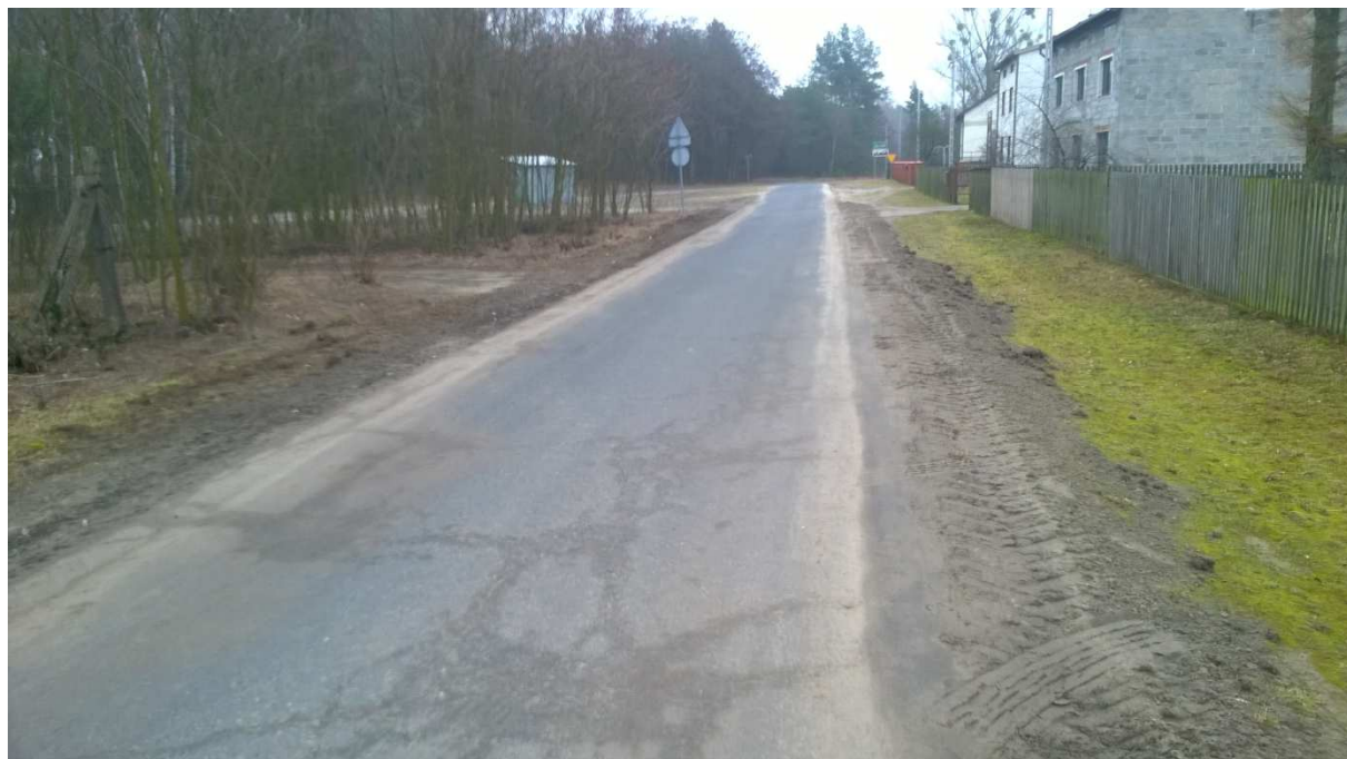
Fot.1. Odcinek I
