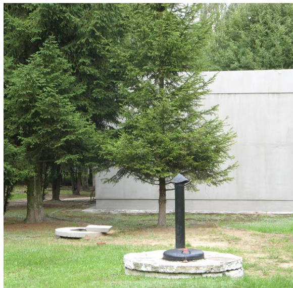
Fot.7. Ujęcie wody podziemnej w Dominowie.
