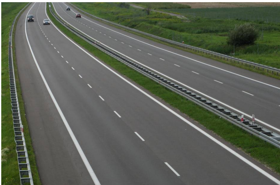
Fot.13. Autostrada A-2, widok z wiaduktu w Gieczu.
