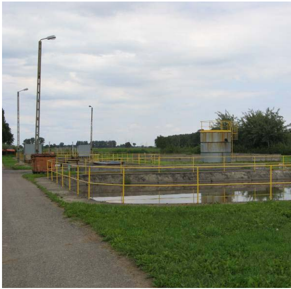
Fot.4. Oczyszczalnia ścieków w Chłapowie.
